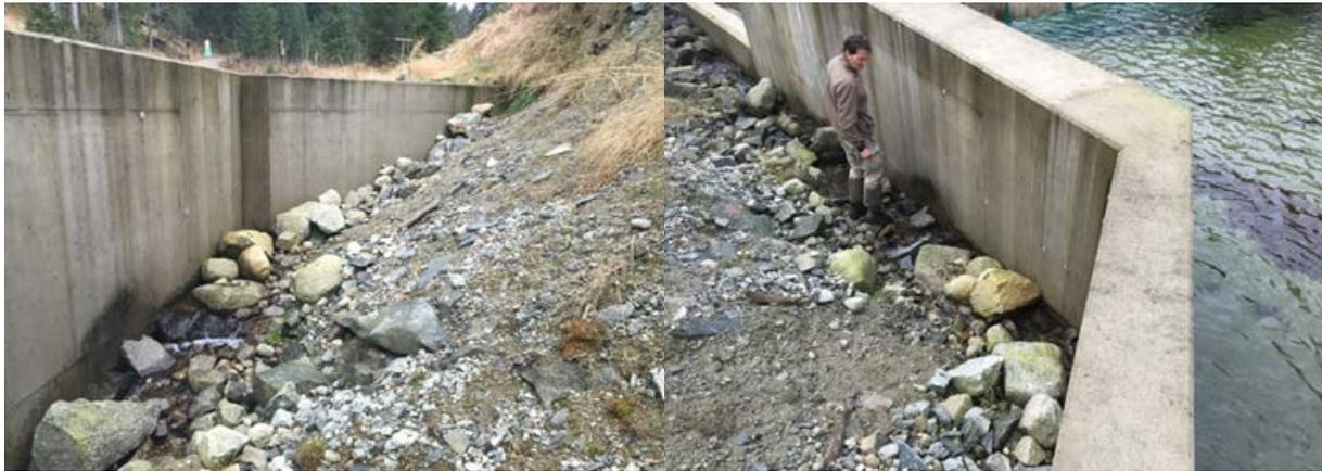
Abb. 3\* und 4\*: Von Regenfällen unterspülter Hang. Die dadurch entstandene Hangrutschung verlegte den Fischaufstieg! Leider versteckt sich der Fischaufstieg hinter der großen betonierten Wehrwange und ist wohl auch für den Kraftwerksbetreiber schwer einsehbar – weil ansonsten der Fischaufstieg unverzüglich wieder hergestellt worden wäre!!
