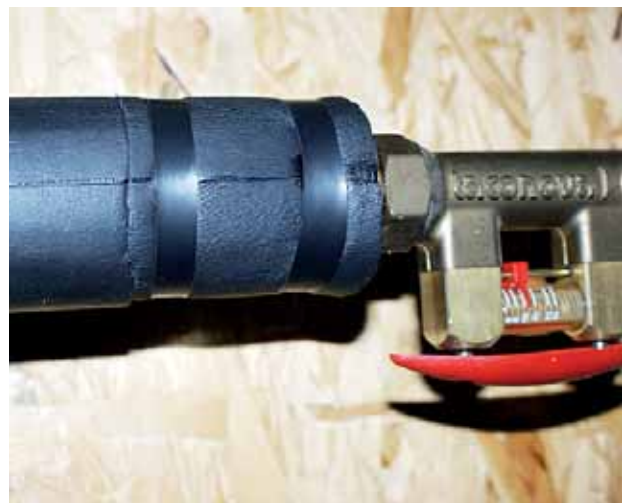
▲ Werden die Minitemperaturdatenlogger überdämmt, ist die Messgenauigkeit für den Anwendungsfall ausreichend.
