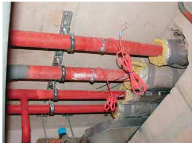
▲ Bei Wand- oder Deckendurchbrüchen muss die volle Dämmstärke durchgezogen werden.
