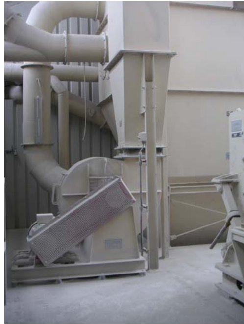
Abbildung 11: Teil einer Wiederaufbereitungsanlage
