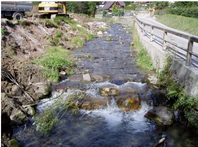
Abb. 1: ursprünglicher Gewässerabschnitt kurz nach Baubeginn
