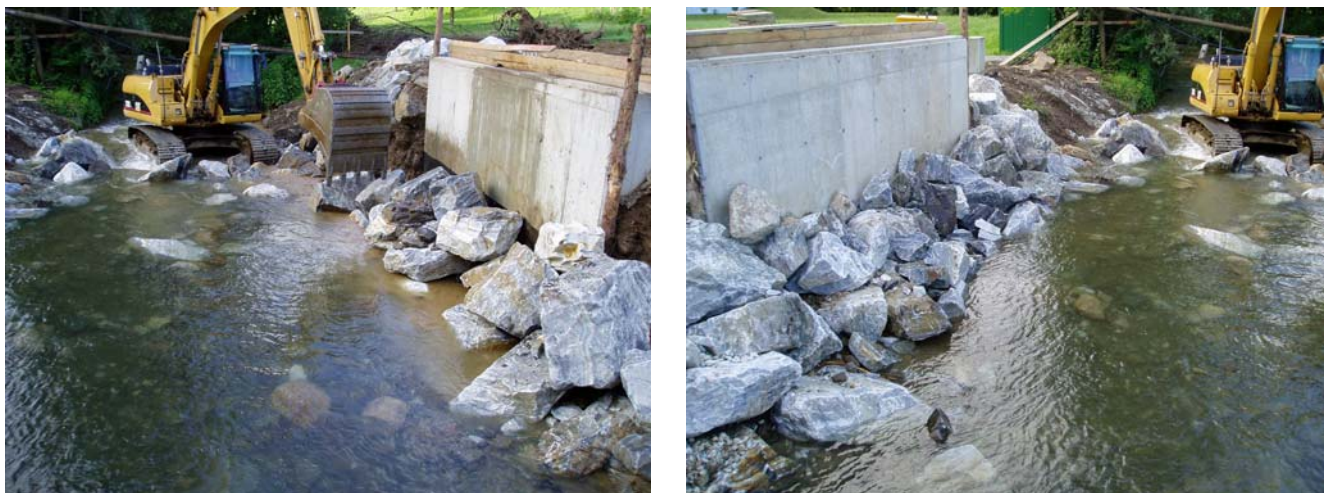
Abbildung 4 – 5: Reparaturmaßnahmen nach der Beanstandung
