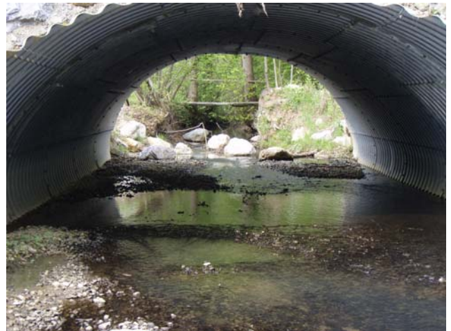
Abb. 6 Sohlüberdeckung mit natürlichem Flussskies
