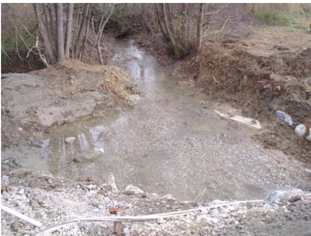
Abb. 3: Abflachung der Ufer und Aufweitung des Gewässers während der Bauphase
