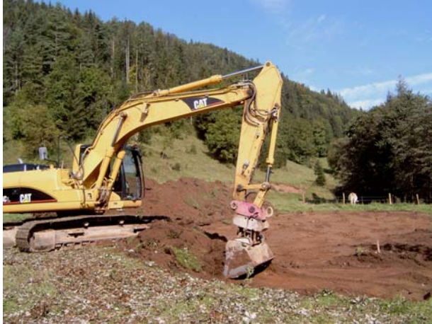
Abb. 2: Entfernung des Oberbodens
