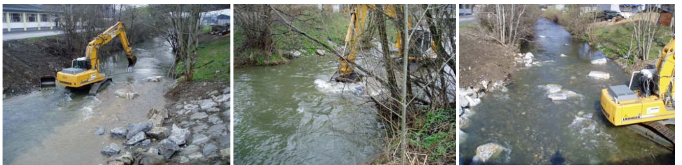
Abb. 7 – 9: Strukturanreicherungen, Rekultivierung, Aufweitung d. Ufer, Schaffung von Tiefenvarianzen und geschwungenen Uferlinien
