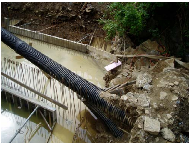
Abb.5 und 6: Zementhaltige Baugrubenabwässer wurden direkt in den Oberwaldbach gepumpt.
