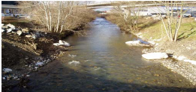
Abb. 1: Baubeginn – steriles Trapezprofil
