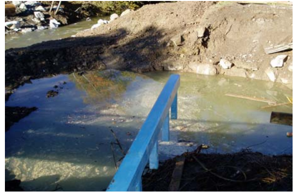
Abb. 4: Wassereinbruch in eine Baugrube
