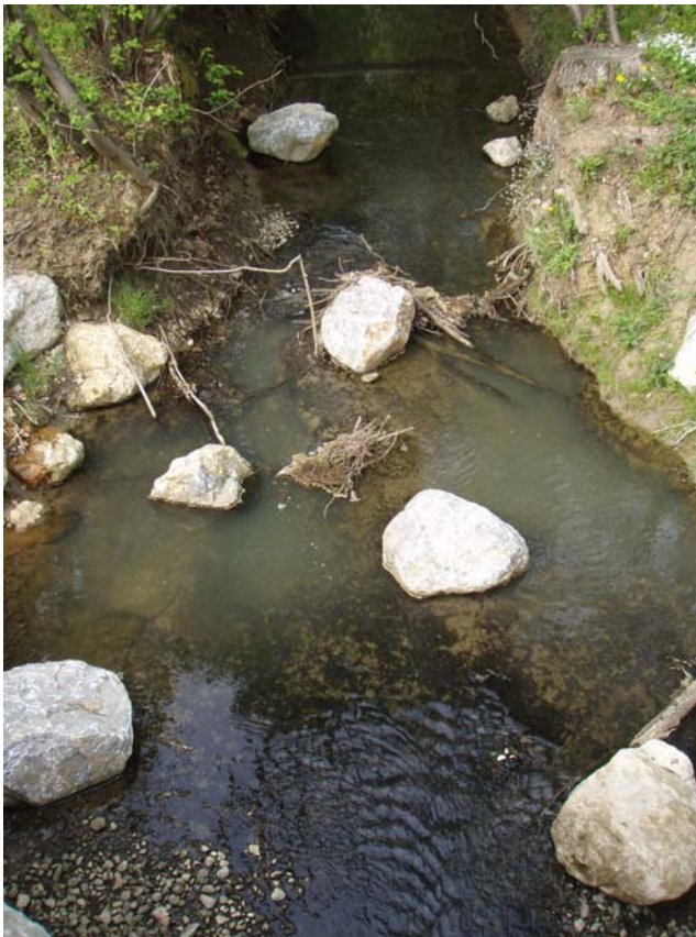
Abb. 7 strukturierte Uferlinien (Aufweitungen, Einengungen), Störsteine zur Dynamisierung des Strömungsbildes nach Bauende
