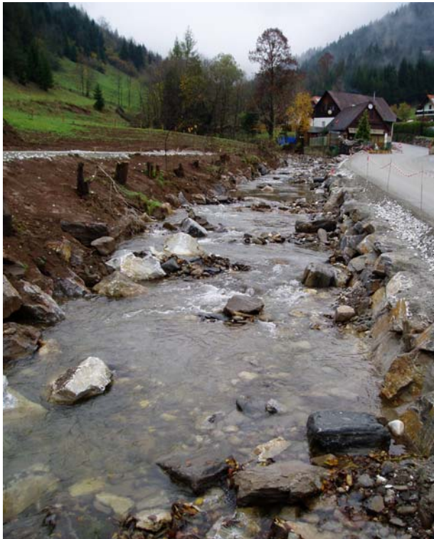
Abb. 8: rechtsufrige Bruchsteinmauer
