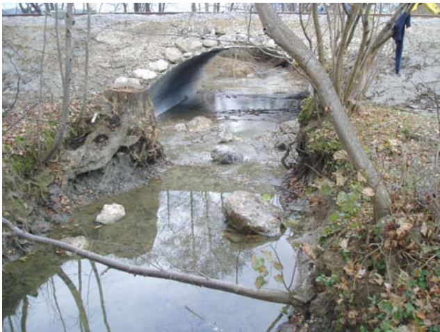
Abb. 5 Erhaltung von Totholzstrukturen (Wurzelstock) als natürliche Ufersicherung und wichtiges Strukturelement (Aufnahme nach Bauende)
