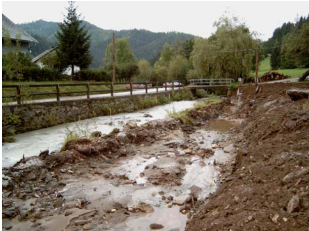
Abb. 5: Aushub des neuen Bachbettes
