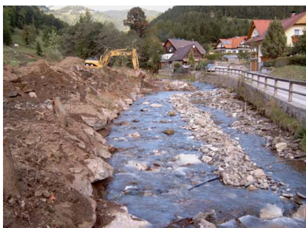
Abb.6 u.7: Strukturierung des neuen rechten Ufers
