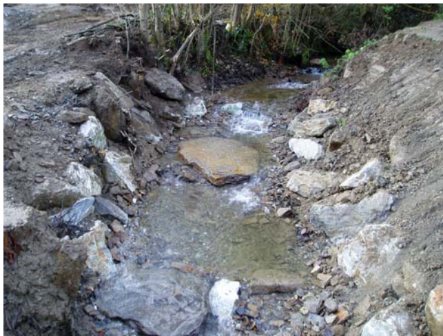
Abb. 2 und 3: Sohlgurt mit Niederwasserrinne (nach Beanstandung); einzelne Strukturen in der Sohle.
