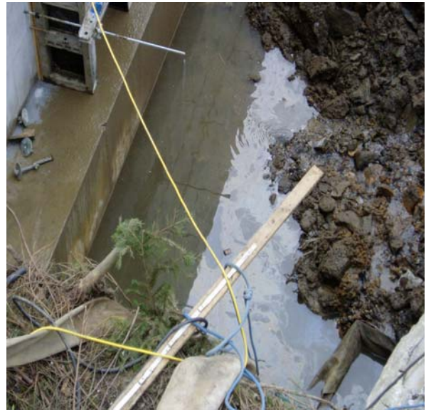
Abb. 4: Wassereinbruch in eine Baugrube
