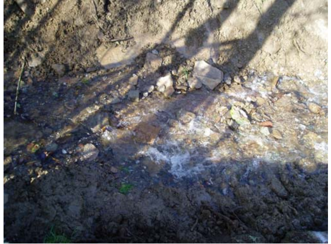
Abb. 1 und 2: Die Sohlpflasterung wurde entfernt, die Ufer wurden bis zur Wasserkante humusiert.
