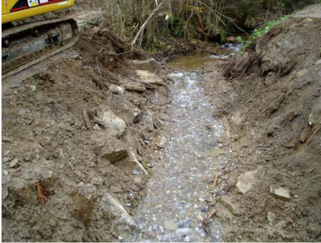
Abb. 1 und 2: Die Sohlpflasterung wurde entfernt, die Ufer wurden bis zur Wasserkante humusiert.
