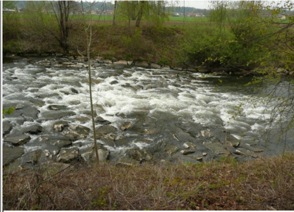
Abbildung 31: Bild oben: Nicht passierbare Steinrampe mit unzureichenden Ruhezeiten und zu turbulentem Strömungsbild. Die Steinrampe wurde im Zuge eines Renaturierungsprojekts 2012 fischpassierbar umgebaut (Bild rechts); Kainach; Gemeinde Hallersdorf, Bezirk Voitsberg.
