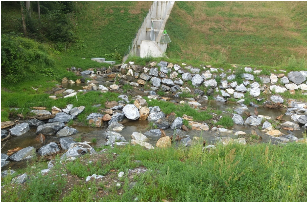
Abbildung 32: RHB Lankowitzbach; Gemeinde Maria Lankowitz; Bezirk Voitsberg; Fischpassierbare Steinrampe als Verbindung des Grundablasses mit dem Bestandsgewässer (2015)
