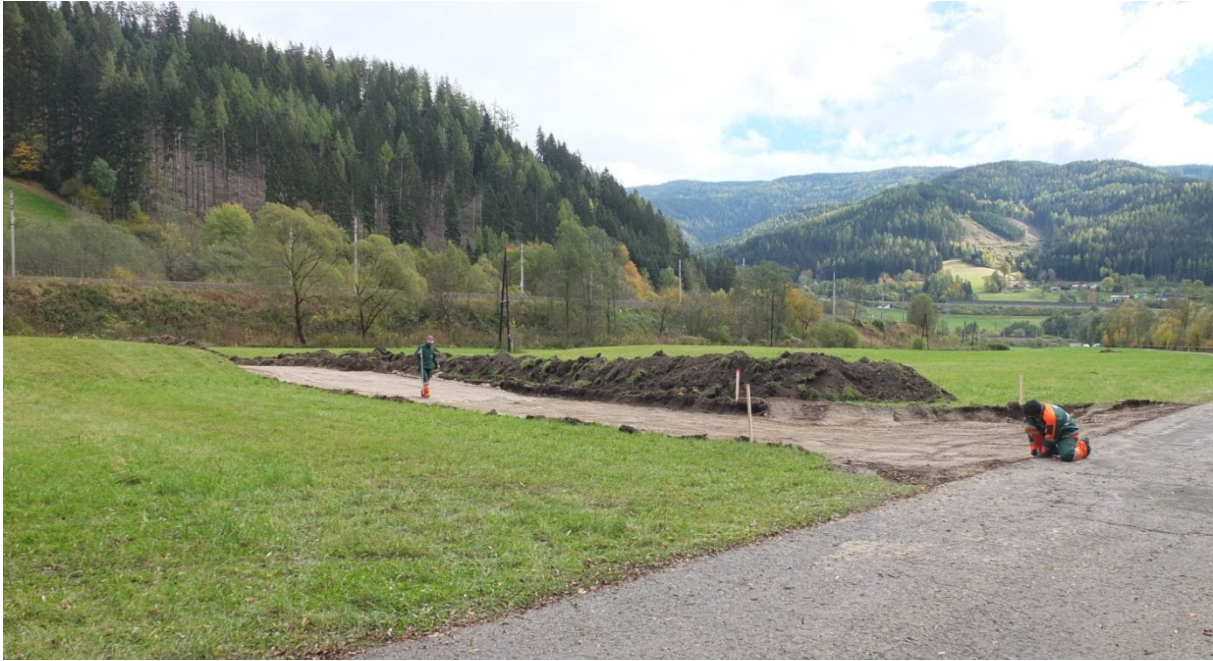
Abbildung 12: Abgezogener und in niedrigen Mieten gelagerter Oberboden; Baustelleneinrichtung für das ÖBB Dammsanierungsprojekt „Wartberger Bogen“, Gemeinde Kindberg (2015)
