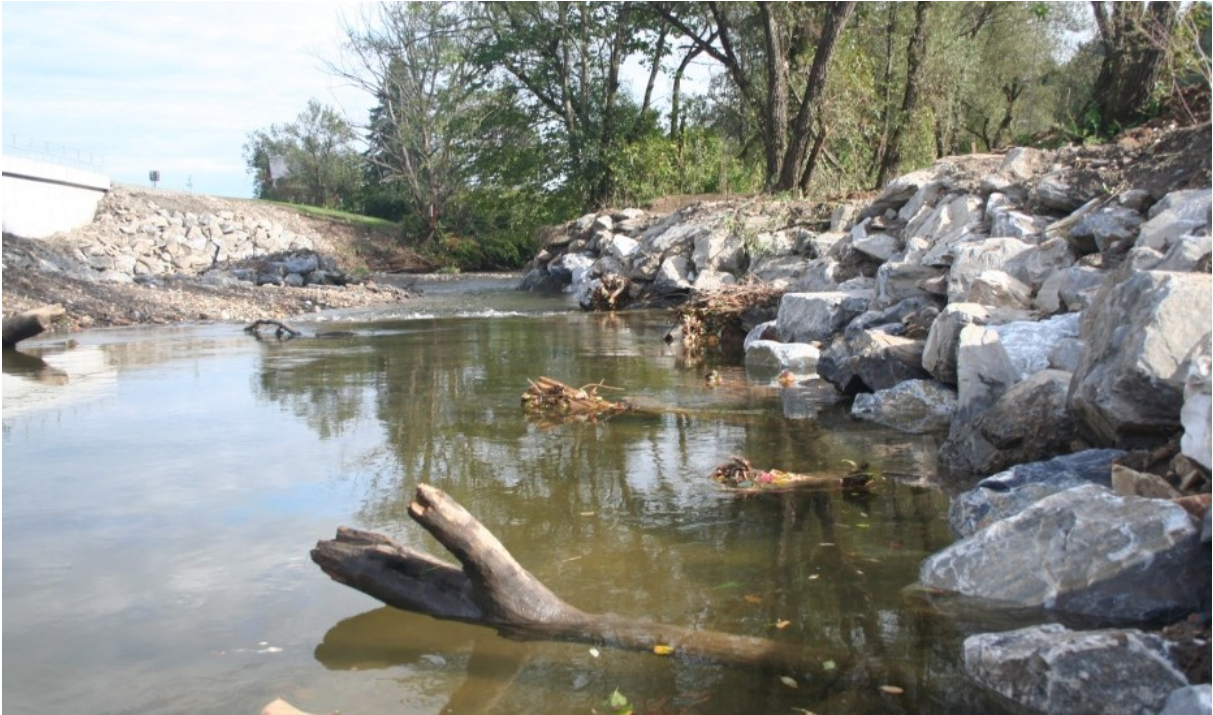
Abbildung 20: Rauer Uferverbau mittels Grobsteinschichtung mit integrierten Totholzstrukturen; Kainach; Errichtung einer Eisenbahnbrücke in der Gemeinde Hallersdorf; Bezirk Voitsberg (2011)
