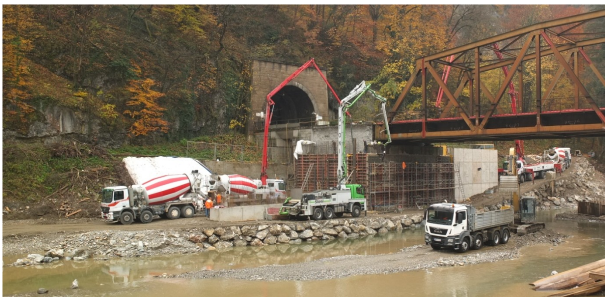
Abbildung 18: Betonierungsarbeiten mit Umschlaggeräten; Neuerrichtung der Kugelsteinbrücke; Gemeinde Peggau (2015)
