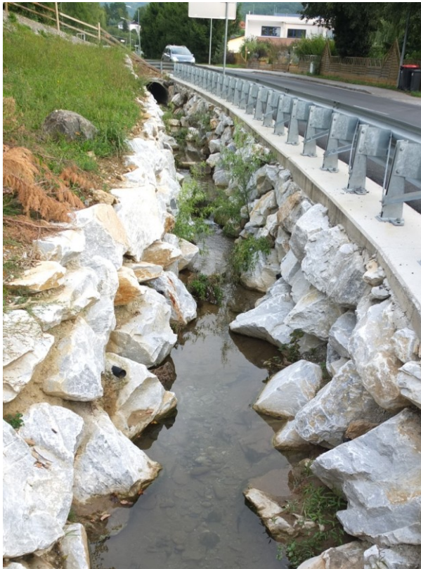
Abbildung 22: links: Rauer Uferverbau mittels Grobsteinschichtung mit und ohne Beton trotz massiver räumlicher Einschränkungen wurden Breiten- und Tiefenvarianzen geschaffen und Totholz eingebaut; Höllbach, Gemeinde Stattegg (2013) rechts: Rauaussteinerung auf Beton mit Totholzeinbauten kurz nach Bauende; unbenanntes Gerinne; Gemeinde Niklasdorf (2015), Bezirk Leoben
