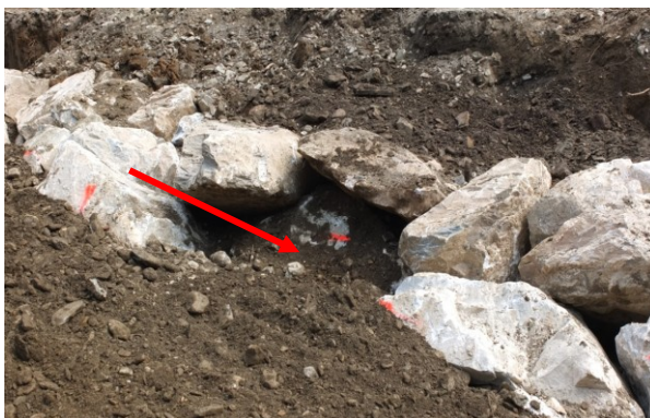
Abbildung 24 links und rechts: Einbau von Fischunterständen bzw. Steinkrebslebensräume (rote Pfeile); (2015)
