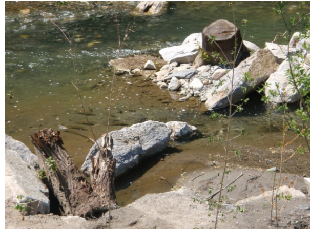
Abbildung 23: links und rechts: Einbau von Totholzstrukturen im Zuge der Errichtung eines rauhen Steinsatzes kurz nach Bauende; Kainach; Bezirk Voitsberg
