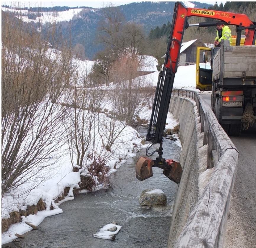
Abbildung 26: Strukturierung der Ufermauer zur Verbesserung der Strukturvielfalt; Weizbach – Oberlauf; (2013)
