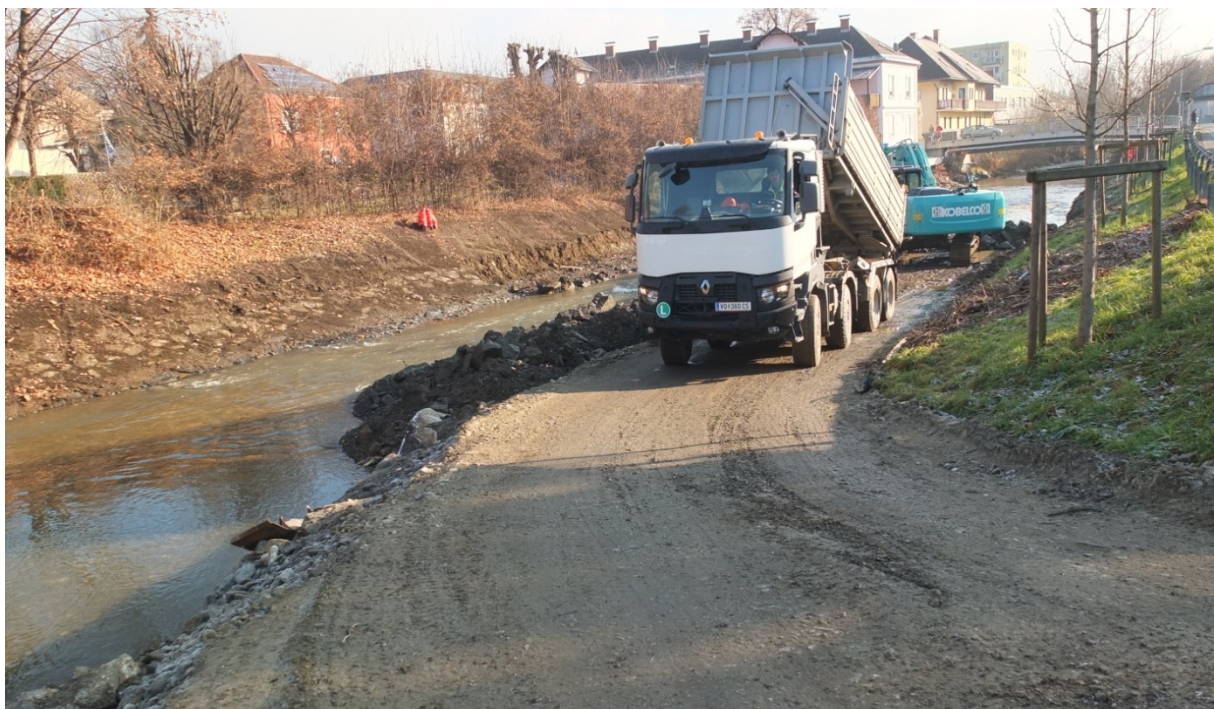
Abbildung 14: Zur Herstellung des HWS-Projekts entlang der Kainach in Voitsberg wurden Baustraßen aus flusseigenem Material in den Gewässerraum errichtet. (2015)
