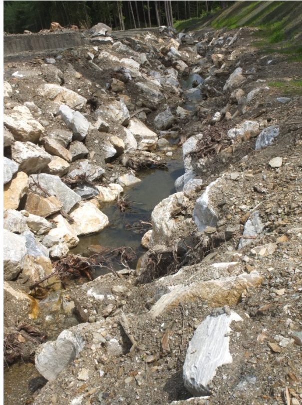
Abbildung 22: links: Rauer Uferverbau mittels Grobsteinschichtung mit und ohne Beton trotz massiver räumlicher Einschränkungen wurden Breiten- und Tiefenvarianzen geschaffen und Totholz eingebaut; Höllbach, Gemeinde Stattegg (2013) rechts: Rauaussteinerung auf Beton mit Totholzeinbauten kurz nach Bauende; unbenanntes Gerinne; Gemeinde Niklasdorf (2015), Bezirk Leoben
