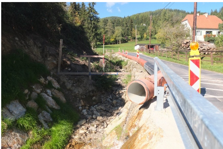
Abbildung 11: Wasserhaltung mittels Verrohrung des Lammerbaches; Gemeinde Kindberg (2015)
