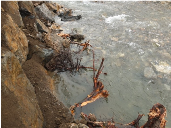
Abbildung 23: links und rechts: Einbau von Totholzstrukturen im Zuge der Errichtung eines rauhen Steinsatzes kurz nach Bauende; Kainach; Bezirk Voitsberg
