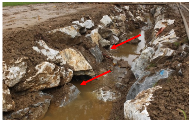
Abbildung 24 links und rechts: Einbau von Fischunterständen bzw. Steinkrebslebensräume (rote Pfeile); (2015)
