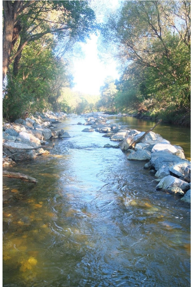
Abbildung 31: Bild oben: Nicht passierbare Steinrampe mit unzureichenden Ruhezeiten und zu turbulentem Strömungsbild. Die Steinrampe wurde im Zuge eines Renaturierungsprojekts 2012 fischpassierbar umgebaut (Bild rechts); Kainach; Gemeinde Hallersdorf, Bezirk Voitsberg.
