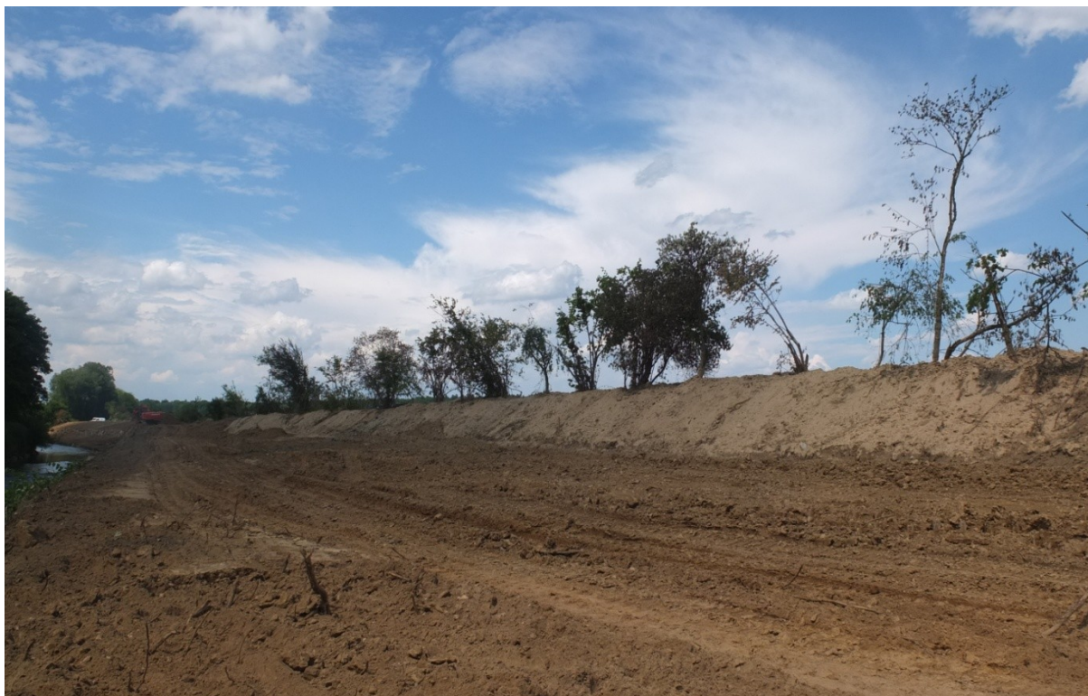
Abbildung 34: Im Zuge von Rodungsarbeiten direkt an die neue Uferböschung gepflanzte Bäume und Sträucher; Gemeinde Bierbaum an der Safen; Safen (2015)
