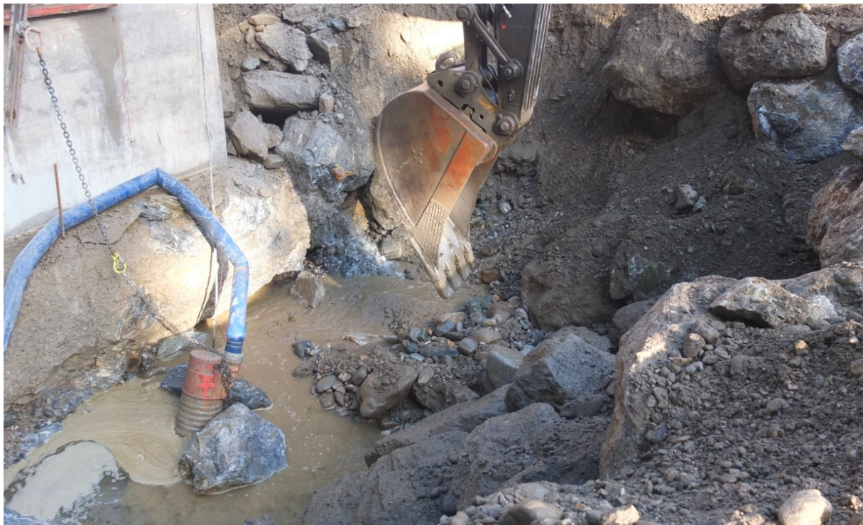
Abbildung 16: Aushubarbeiten bei massivem Wasserandrang; Baumaßnahme: Verstärkung des Widerlagers Graz, Eisenbahnbrücke Kugelstein; Gemeinde Peggau (2015)
