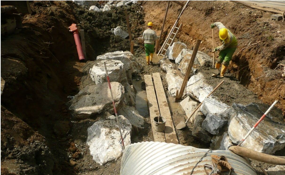
Abbildung 17: Betonierungsarbeiten mit Magerbeton und funktionierender Wasserhaltung; Errichtung eines Straßendurchlasses, Höllbach, Gemeinde Stattegg (2012)
