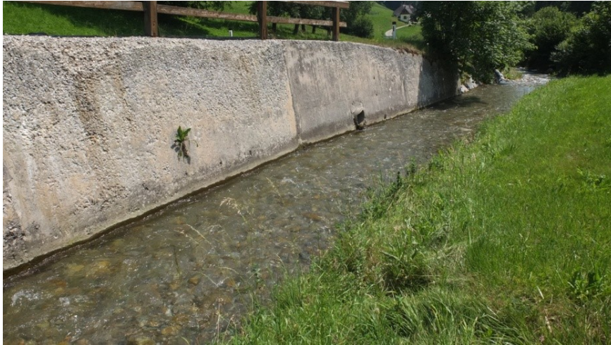
Abbildung 25: Durch die unstrukturierte Ufermauer entsteht ein gleichförmiges, sehr unnatürliches Strömungsbild; Weizbach Oberlauf; (2012)
