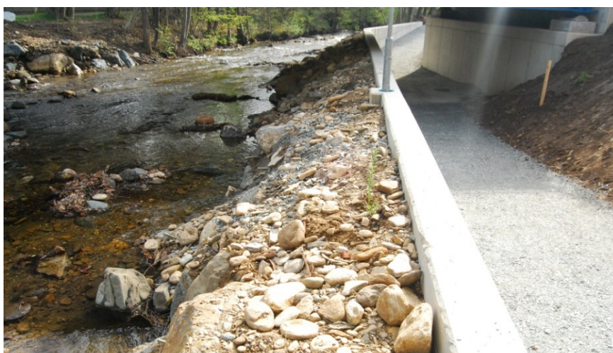
Abbildung 27: Zur Strukturierung der Ufermauer wurde eine raue Grobsteinschichtung mit Totholzschichten vorgesezt. Laßnitz, Bez. Deutschlandsberg; (2012)
