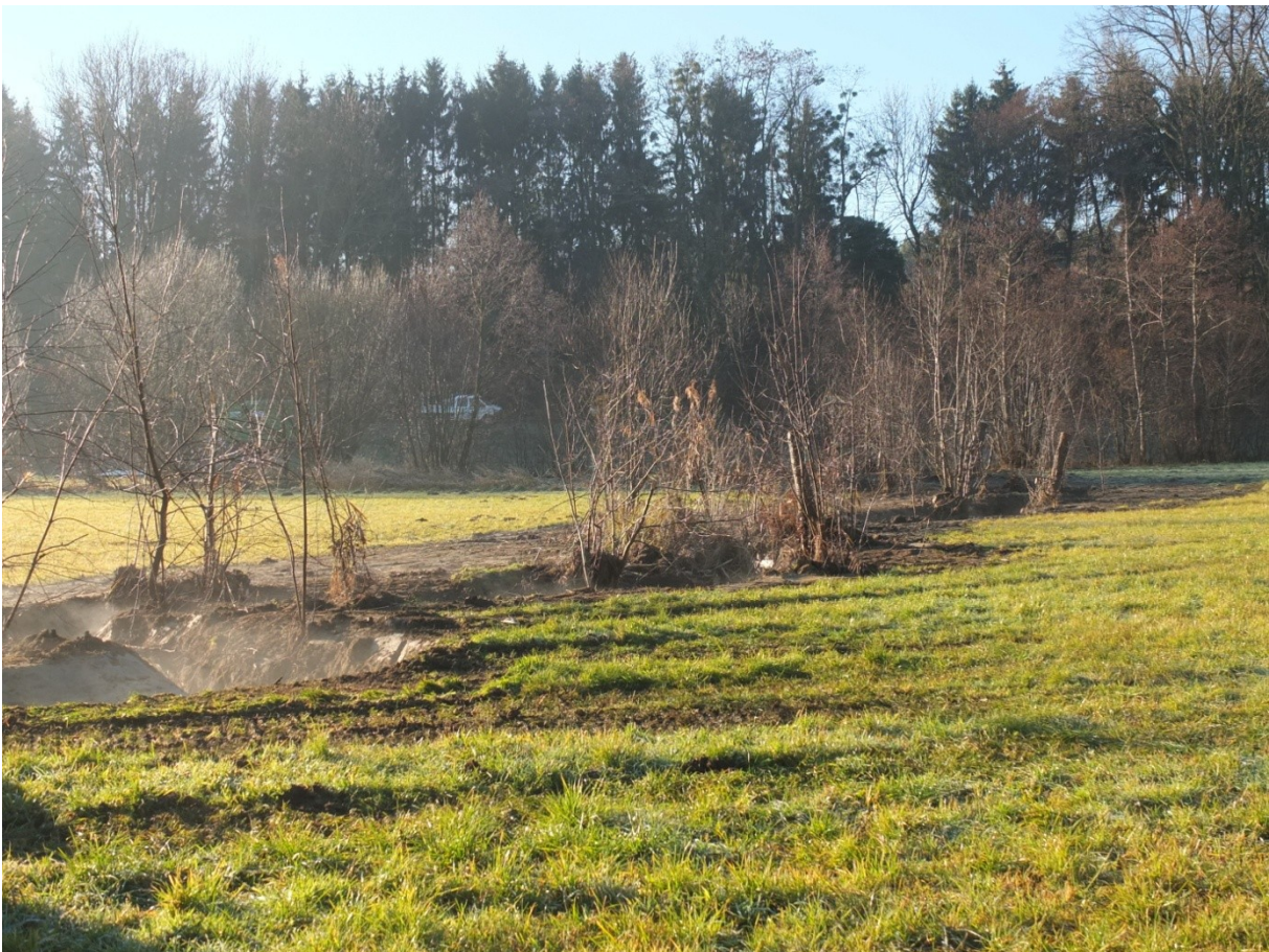
Abbildung 13: Neuerrichteter Bachlauf mit aus der Natur entnommenen und wiedereingesetzten Ufergehölzen; Bauvorhaben: RHB Erlenbach; Marktgemeinde Thal, Bezirk Gösting/Graz (2015)
