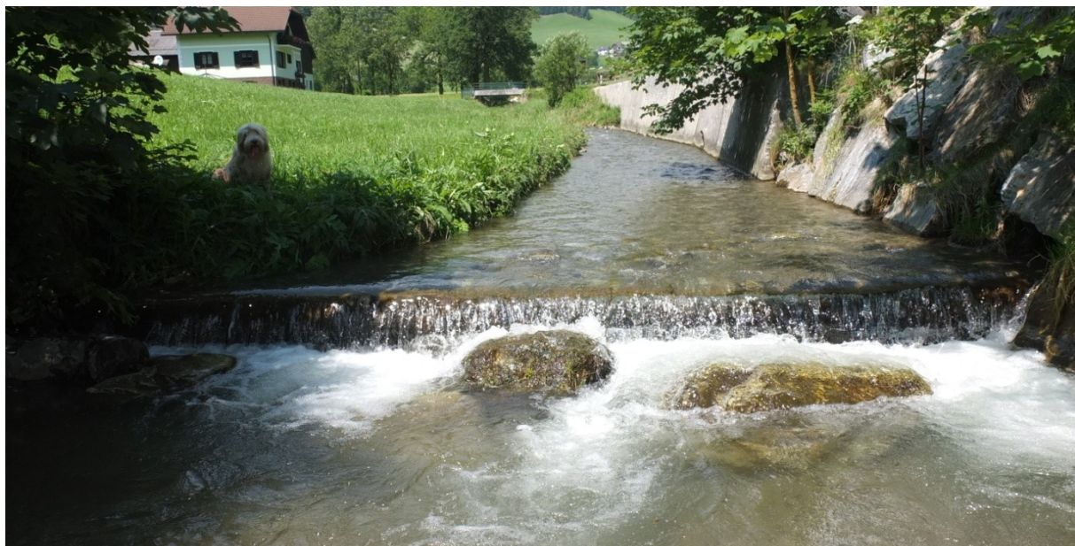
Abbildung 28: Nicht passierbare Holzsohlschwelle; welche im Zuge eines Renaturierungsprojekts entfernt wurde; Oberlauf des Weizbaches (2012)
