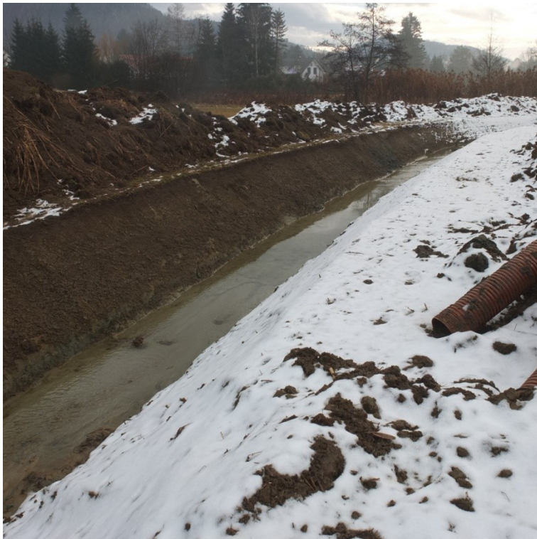
Abbildung 10: Herstellung eines unbefestigten temporären Umgehungsgerinnes als Wasserhaltungsmaßnahme für die Errichtung eines Rückhaltebeckens am Erlenbach; Marktgemeinde Thal, Bezirk Götting, Graz (2016)
