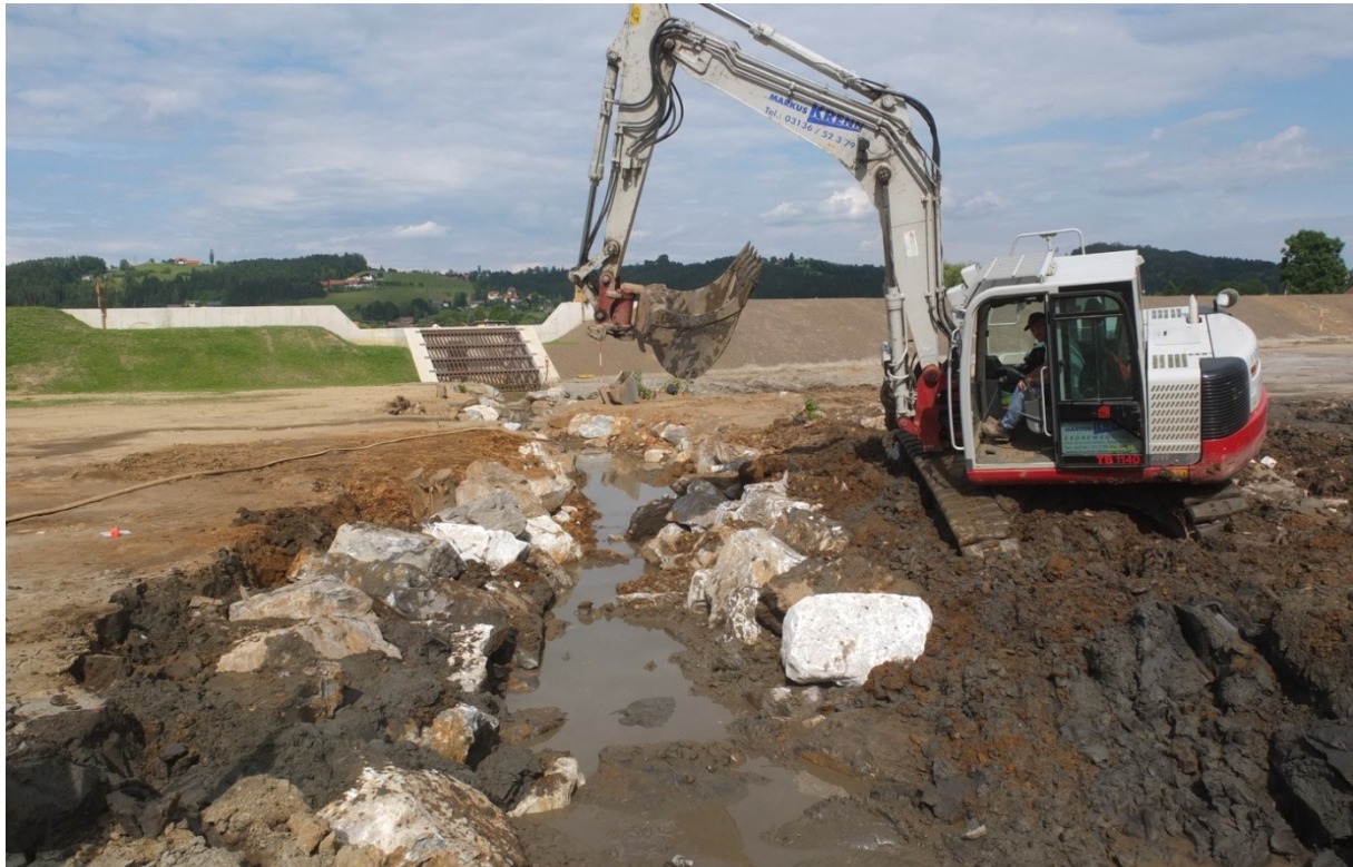
Abbildung 15: Aushubarbeiten bei der Errichtung eines neuen Bachlaufs; Bauprojekt: RHB Forstbauerbach, Gemeinde Krottendorf; Bezirk Voitsberg (2014)
