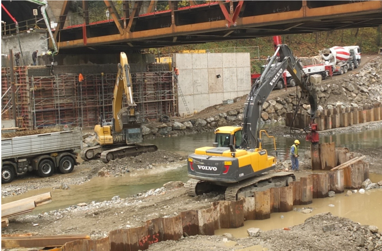
Abbildung 7: Einziehen von Spundwänden zur Errichtung eines Hilfsfundament bei der Errichtung der Kugelsteinbrücke über die Mur, Gemeinde Peggau (2015)
