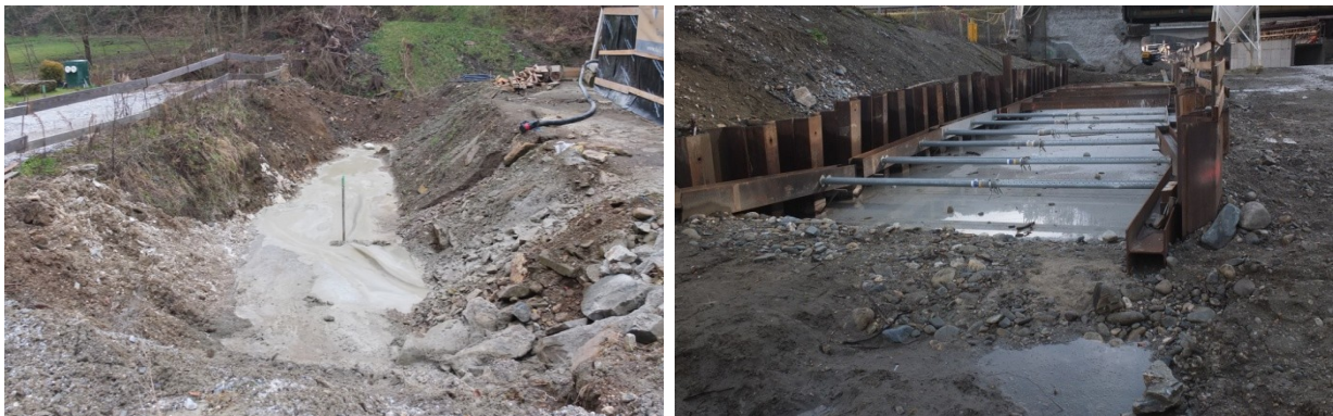
Abbildung 6: links: Waschplatz während der Betonierungsarbeiten am Sperrbauwerk des RHB am Lankowitzbach, 2012/2013; rechts: Absetzbecken mit zementhaltigen Baugrubenwässern im Baustellenbereich zur Erneuerung der Kugelsteinbrücke/ Gemeinde. Peggau (2016)
