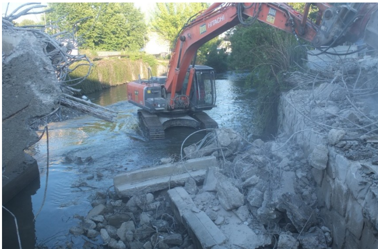
Abbildung 33: Abriss einer Straßenbrücke über die Kainach im Stadtgebiet Voitsberg ohne ökologische Vorkehrungen. (2015)
