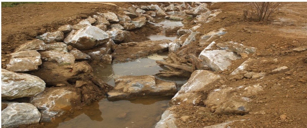
Abbildung 29: Einbau von passierbaren Steinsohlgurten während der Bauphase; Forstbauerbach; Gemeinde Krottendorf; Bezirk Voitsberg; (2013)
