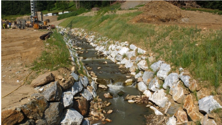
Abbildung 9: Ufergesichertes Umgehungsgerinne zur Errichtung des RHB am Lankowitzbach /Gemeinde Maria Lankowitz; Bezirk Voitsberg. (2013)
