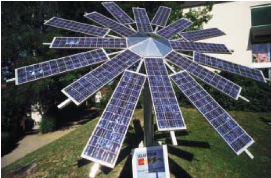
PV-Anlage in Pischelsdorf
