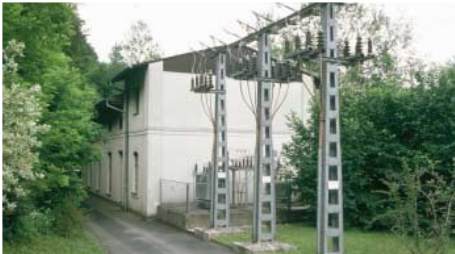
Kleinwasserkraftwerk, Pichler-Werke Weiz
