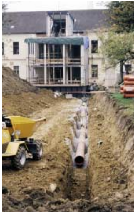
Die Verlegung der jeweils 80 Meter langen Einzelrohre. Im Hintergrund ist das mit konditionierter Zuluft zu versorgende Klosterareal zu sehen.
