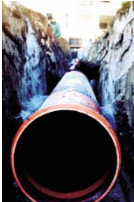
Die acht parallelen PVC-Rohre weisen eine Nennweite von 400 Millimeter auf. Die Verlegetiefe der Rohre beträgt im Mittel 2 Meter.
