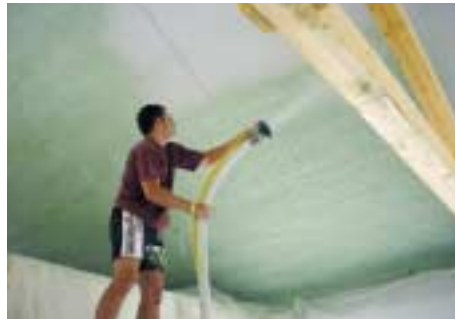
Herstellung einer Schallabsorberschicht aus Zellulose
