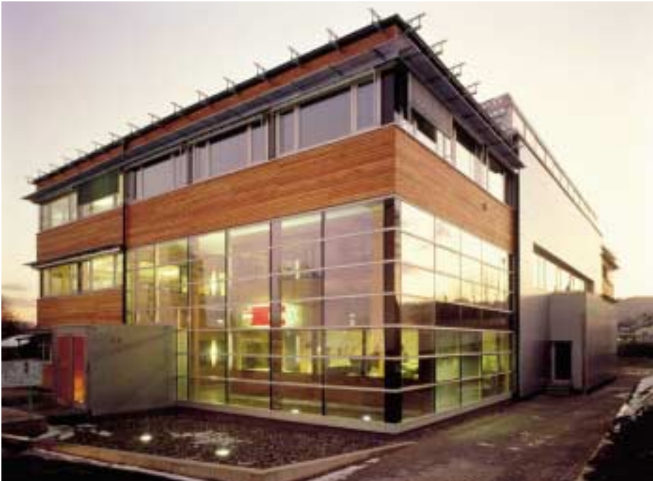
Bürogebäude: Weizer Energie-Innovations-Zentrum
