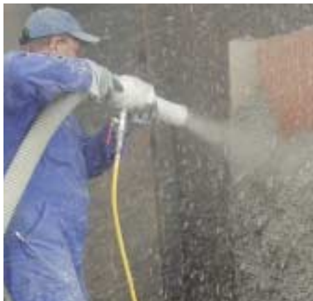
Anspritzversuch von Zelluloseflocken
