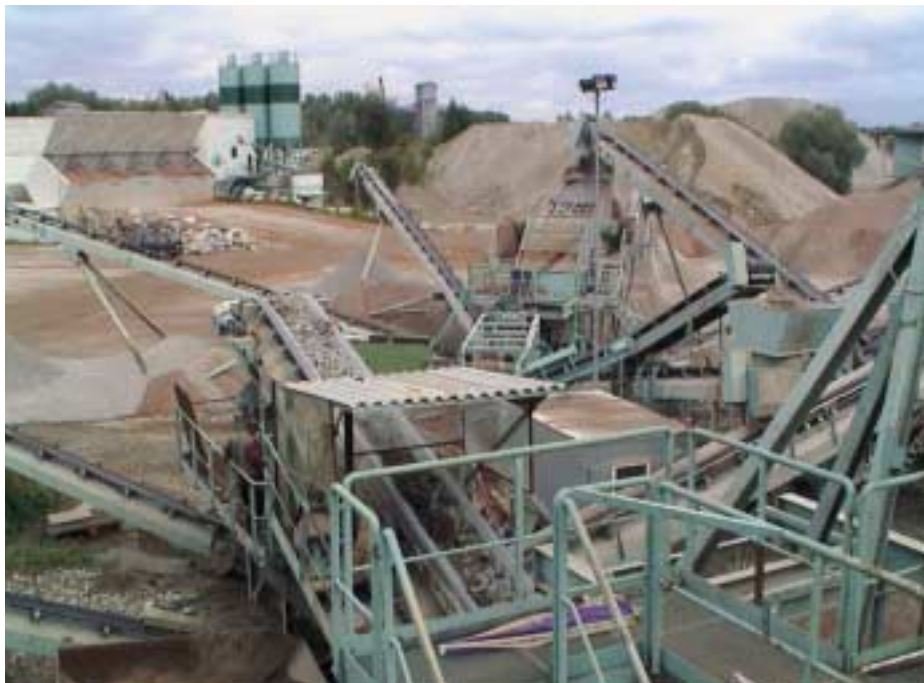
Aufbereitungsanlage für Recyclingbaustoffe
