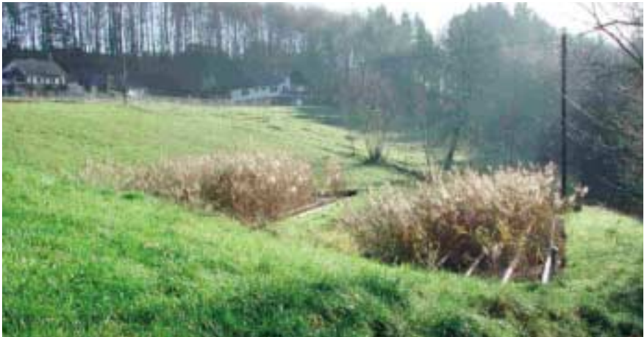
Vererdungsbecken Dornegg (150 EWG) Fertig gestellte Anlage im Frühjahr 2000
