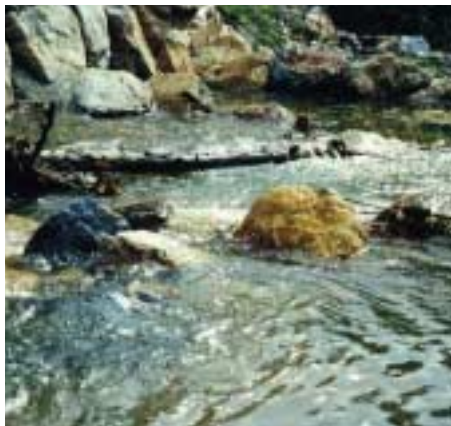
Umbau in Sohlrampe in Riegelbauweise
