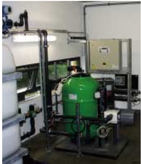
UV-Entkeimungsanlage (Foto: Zivilingenieur Friedrich – Weiz)
