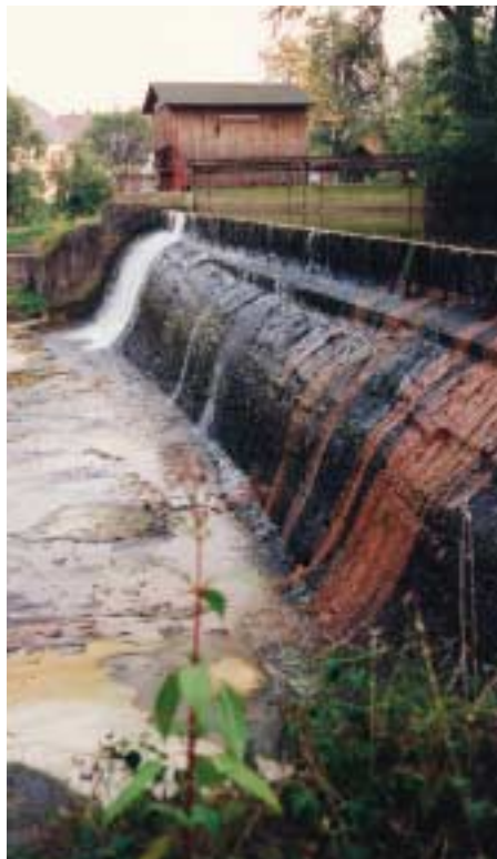
Wehranlage in der Gemeinde Lafnitz
