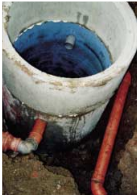
Sperrbrunnen nach einem Austritt von Heizöl (ein Sperrbrunnen verhindert, dass im Boden befindliches Öl durch das Grundwasser weitertransportiert wird)
