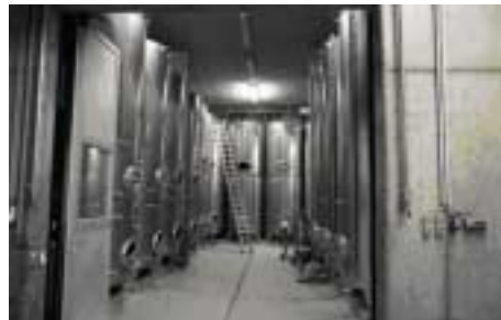
Kellereiraum mit Weintankbehälter
