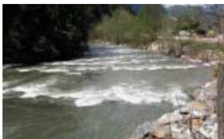
Umbau in eine Sohlrampe in lockerer Bauweise
