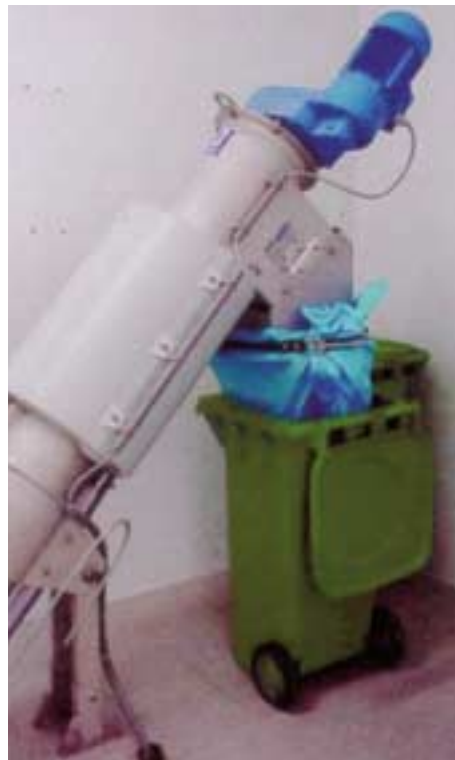
Spiralsiebrechen mit Rechengutentwässerung
