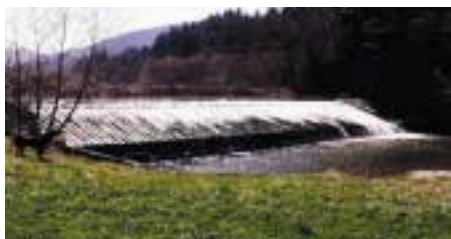
Wehranlage am Irdningbach
