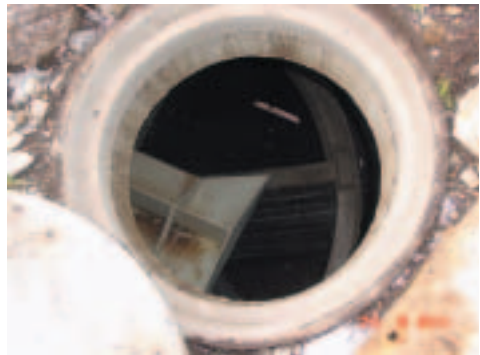
Blick in die Bodenkörperfilteranlage (Foto: DI Kaiser, Judendorf-Straßengel)
