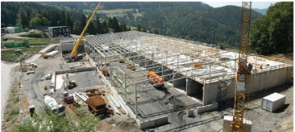
MBA Frohnleiten – Baustelle Sommer 2003
