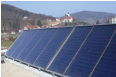
Ansicht der am Flachdach des Demonstrationsobjektes „Nittnergasse“ positionierten Kollektoranlage
