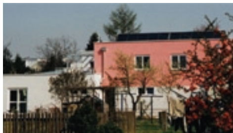
Südansicht des Demonstrationsobjektes „Nittnergasse“ nach Baufertigstellung
