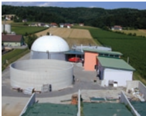
Biogasanlage St. Stefan im Rosental
