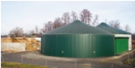
Biogasanlage in Halbenrain
