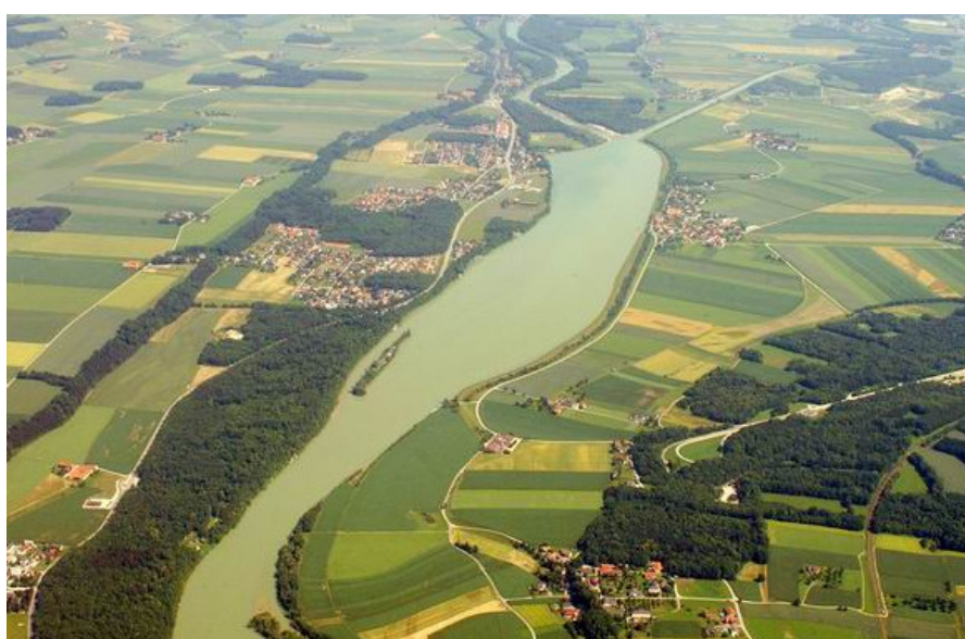
Stauhaltung an der Enns bei Kronsdorf / OÖ (Quelle: © Kdo Luftaufklärung / BMLV)
