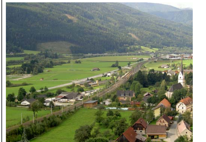
Gemeinde Gaishorn Richtung Süd-Westen (im Hintergrund rechts: Fa. Systemholz, Mitte: neue Vorrangzone Industrie und Gewerbe) Quelle: freiland Umweltconsulting
