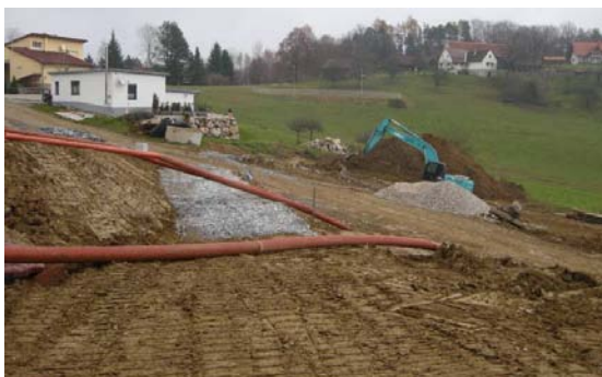
Provisorische Oberflächenentwässerung
