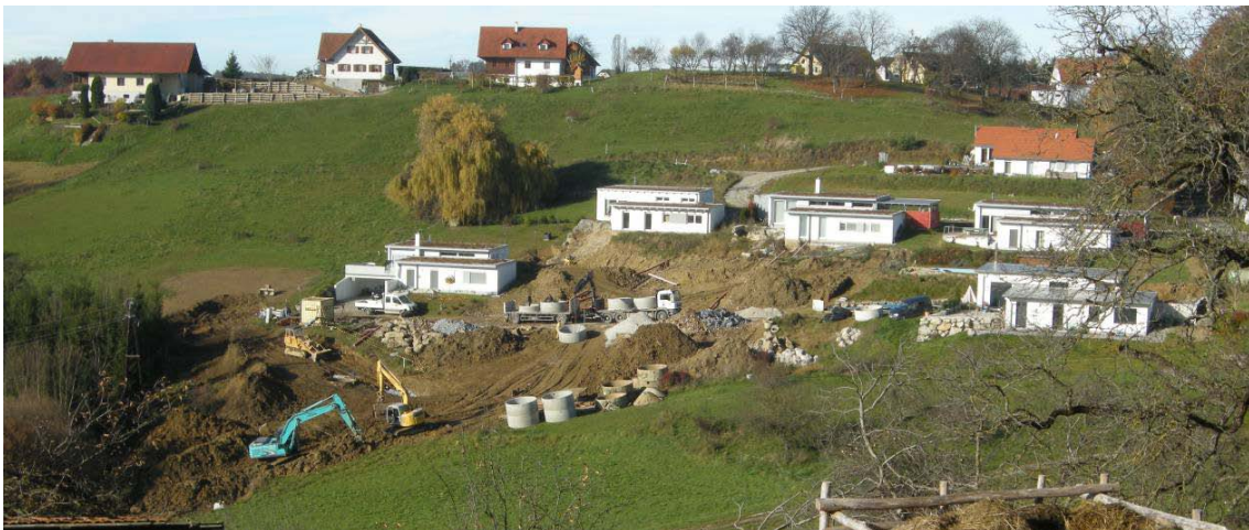
Gesamtansicht der Rutschhangsanierung „Am Wiesengrund“
