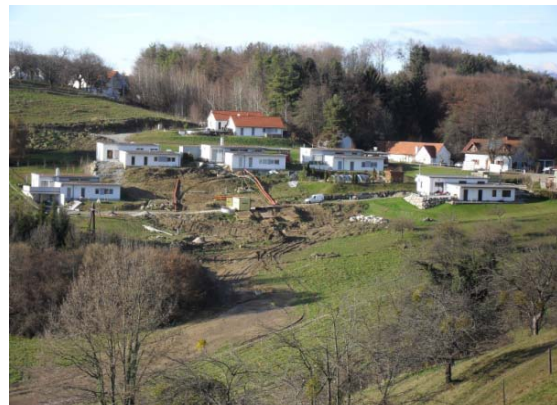
Rutschhangsanierung „Am Wiesengrund“ Gemeinde Langegg bei Graz
