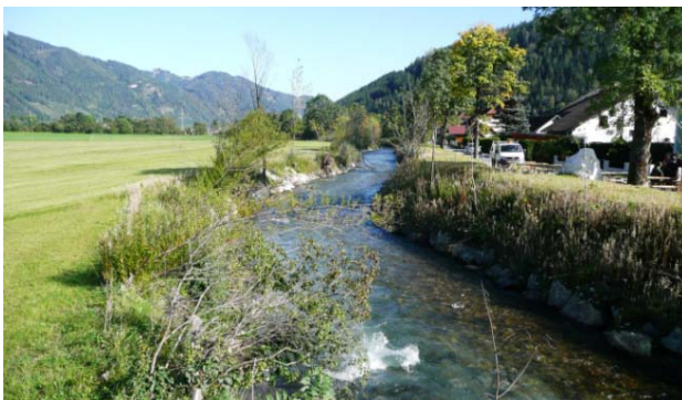
Liesing, Kalwang: Verlegung des Bachbettes zur Errichtung eines Hochwasserschutzdammes
