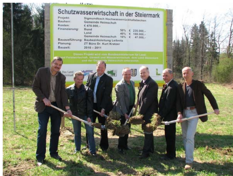
Spatenstich für das Hochwasserrückhaltebecken Sigmundbach in Heimschuh
