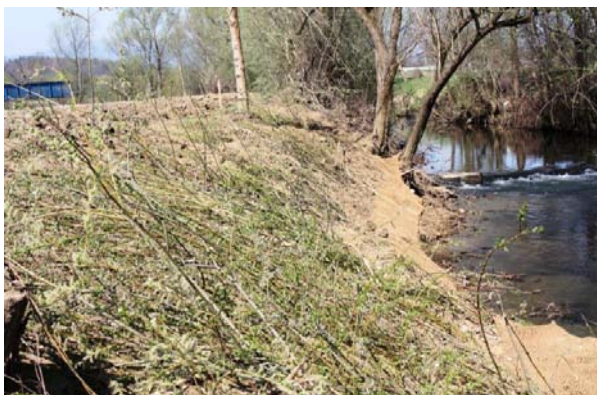
Stainzbach bei Wohlsdorf, Beispiel Versuchsfläche 6: Errichtung einer Weidenspreitlage zur Verdrängung des Japan-Flügelknöterichs durch zukünftige Beschattung und Nährstoffkonkurrenz durch Weiden
