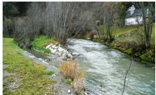
Aschbach, Gußwerk: Errichtung einer Hochwasserabflussberme mit Seitengerinne, Abbau des Gefälles durch eine Pendelrampe
