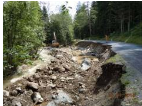
Hochwasser am Rantenbach
