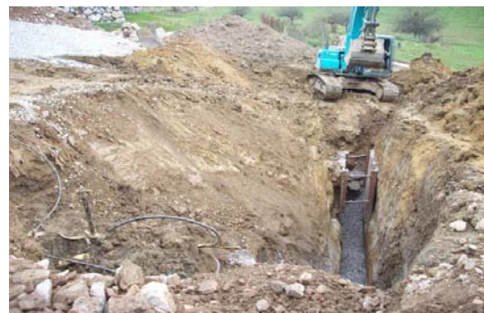
Baugrube zur Herstellung der Tiefendrainagen
