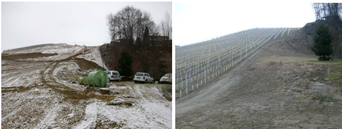
Erdarbeiten im Zuge der Bauphase und Gelände nach Fertigstellung
