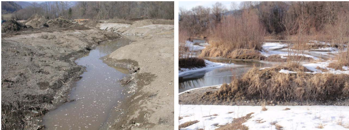
Gewässerentwicklung am Beispiel Mur: St. Peterer Au - Bauphase im Jahr 2005
