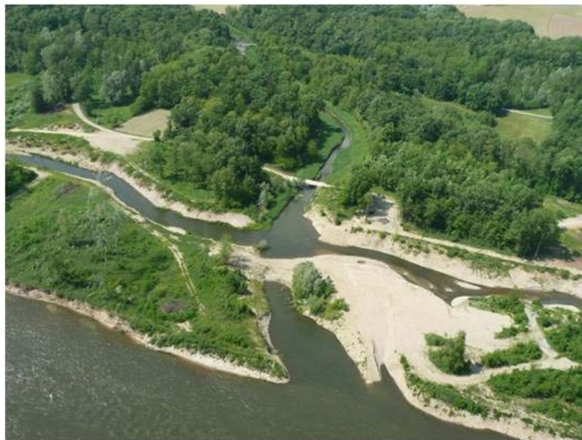
Umgestaltung des Saßbachmündung im Bereich der Muraufweitung in Gosdorf
