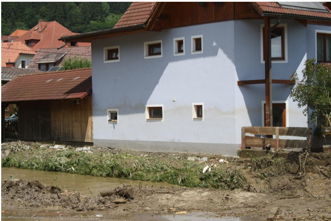
Abgelöstes Wohnobjekt in Niederwölz
