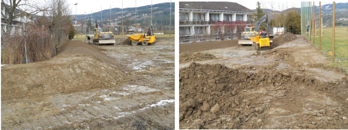
Bau des Rückhaltebeckens 2 am Sportplatz in Stubenberg am See
