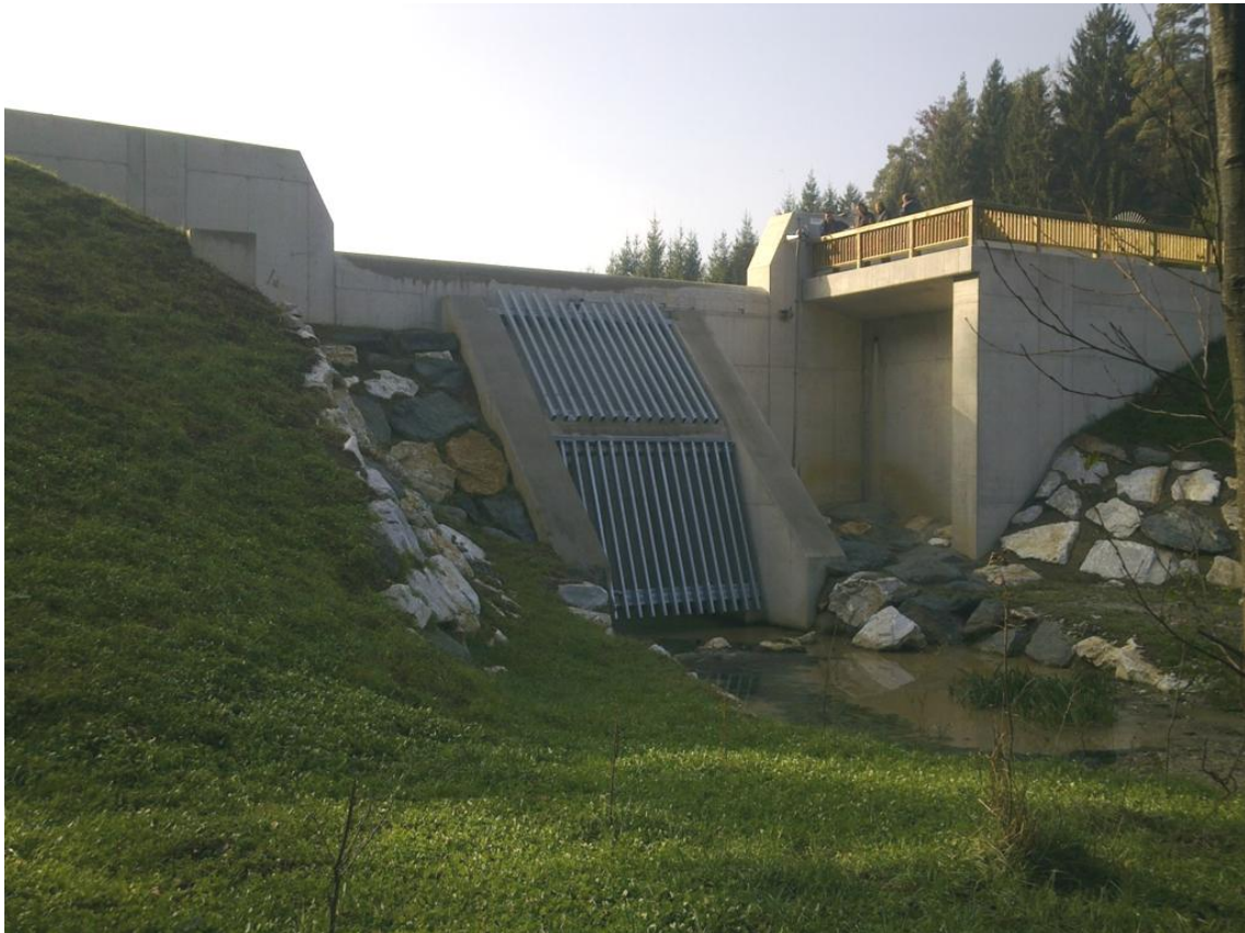
Rückhaltebecken Oberbergbach in Hitzendorf
