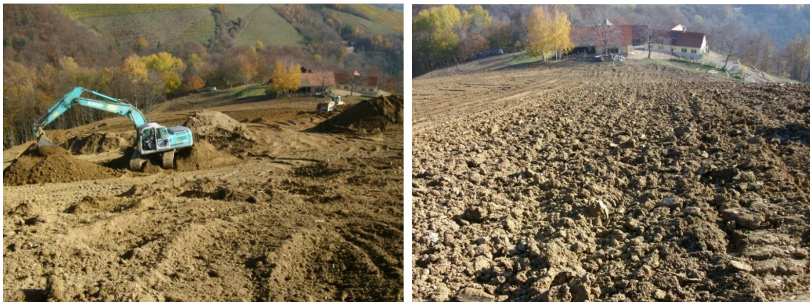
Weingartenanlage Schneeberger, KG Brudersegg während und nach Baumaßnahmen
