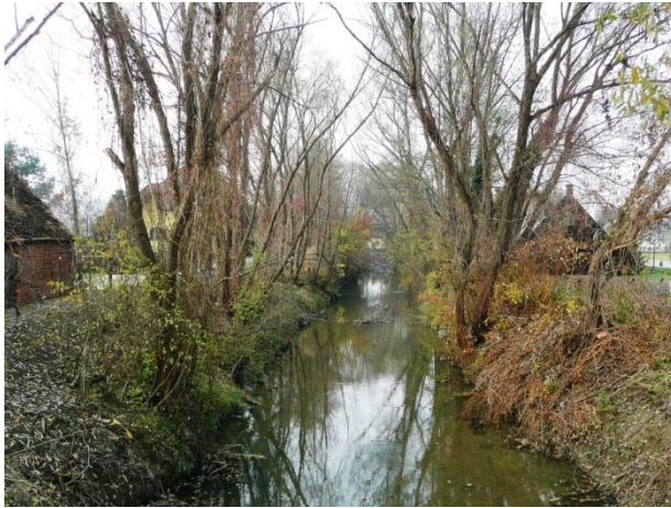
Ilzbach (Sinabelkirchen) nach Bauausführung: Hauptaugenmerk war der Schutz und die Erhaltung des vorhandenen Uferbewuchses.
