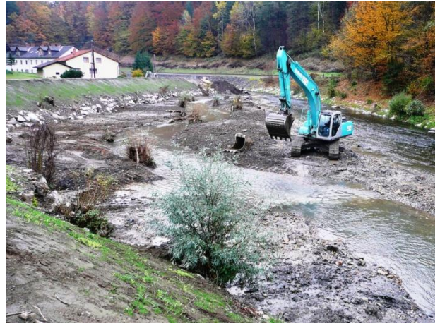
Kainach, Voitsberg: Gestaltung einer Aufweitung durch Herstellung eines neuen Seitengerinnes. Es wurden neue Fischhabitate durch Tief- und Flachwasserzonen geschaffen und vorhandene Wurzelstöcke als Strukturelemente wiedereingebaut.
