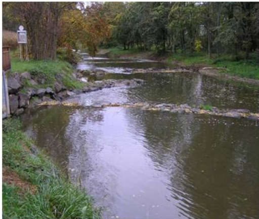
Rückgebaute Kontinuumsunterbrechungen (Schwarzaubachmündung)
