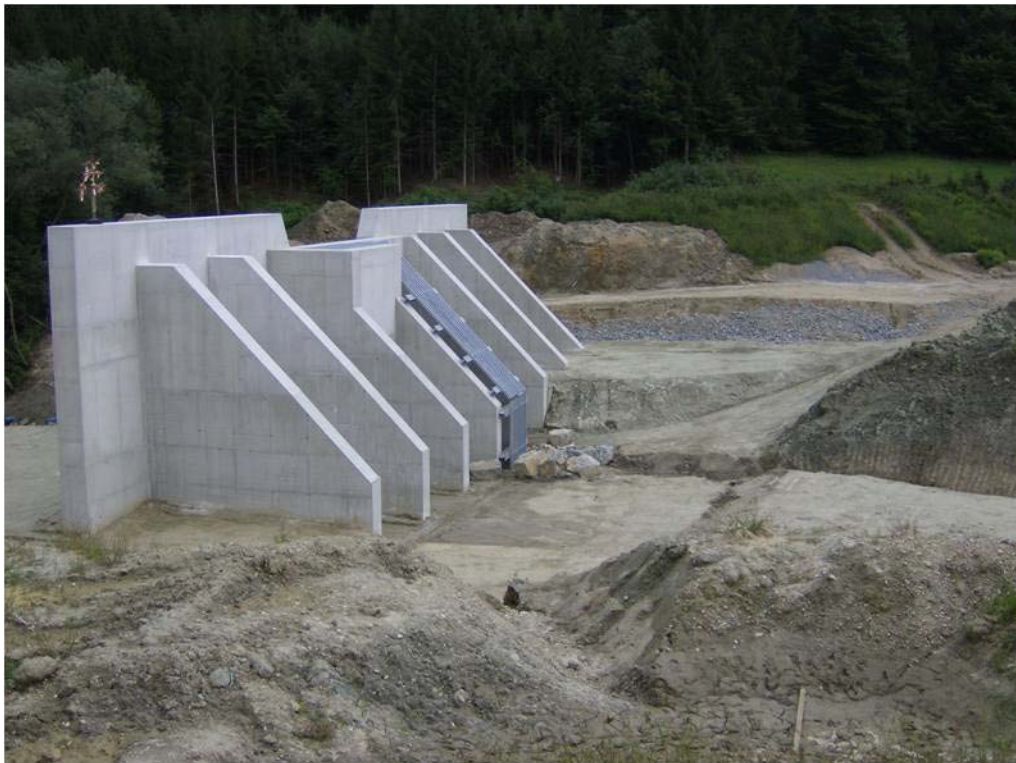
Hochwasserrückhaltebecken Labuchbach in der Gemeinde Urscha
