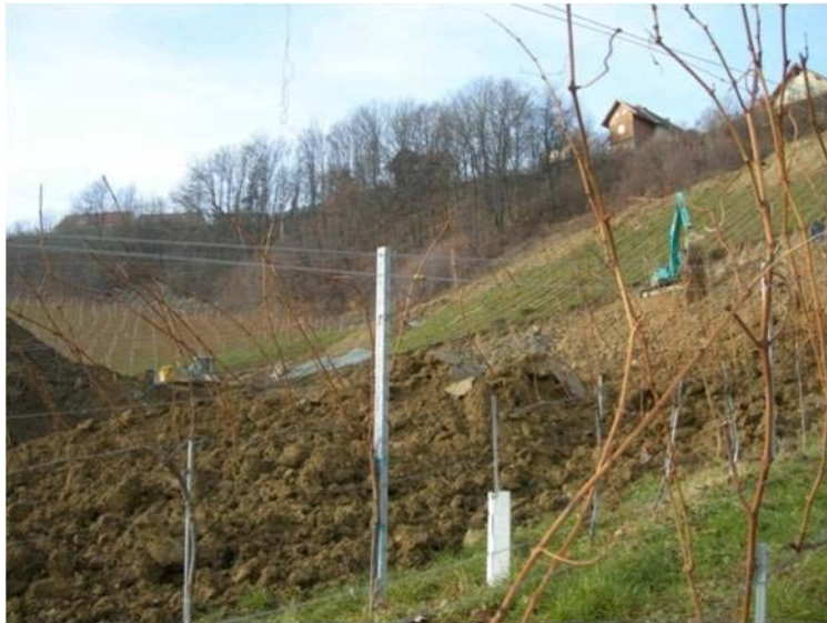
Rutschungssanierung in der Gemeinde Gamnitz
