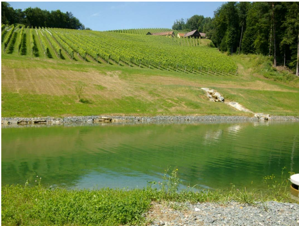
Fertiggestellte Anlage zum Wasserrückhalt für Weinbaubewässerung
