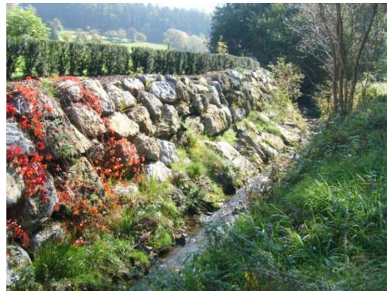
Längsbauwerk am Oisnitzbach
