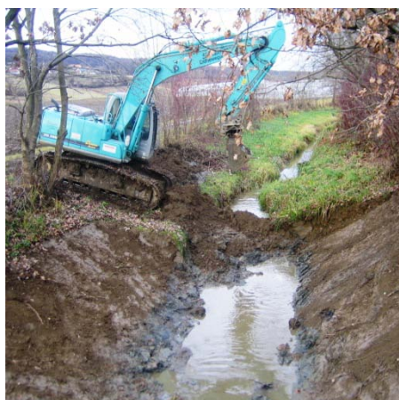
Drauchenbach – Räumung und Entfernen der Halbschalen
