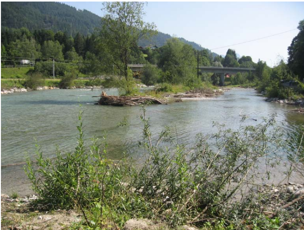
Hochwasserschutz und Gewässerstrukturierung an der Enns westlich von Schladming
