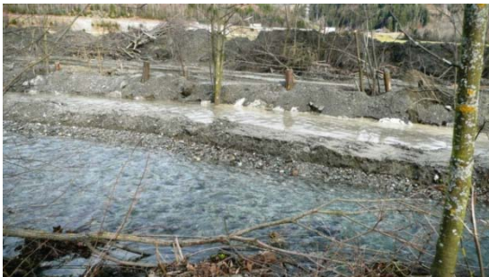
Verlegung des Bachbettes der Liesing bei Kalwang
