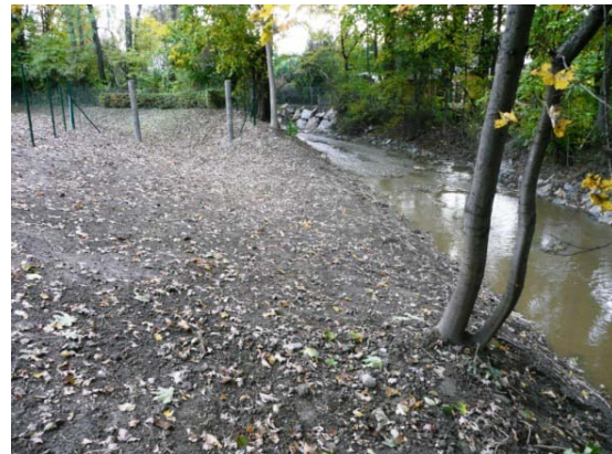
Schöckelbach 1. Bauabschnitt (Sachprogramm Grazer Bäche): Aufweitung im Bereich Gasthaus Pflieger und Hochwasserentlastungsmulde beim Stukitzbad
