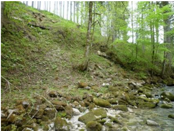
Abbildung 69: Zerstörte Grobsteinschichtung orografisch rechtsseitig zur Sicherung der Geländeoberkante/ Straße (lt. Angabe WLW)
