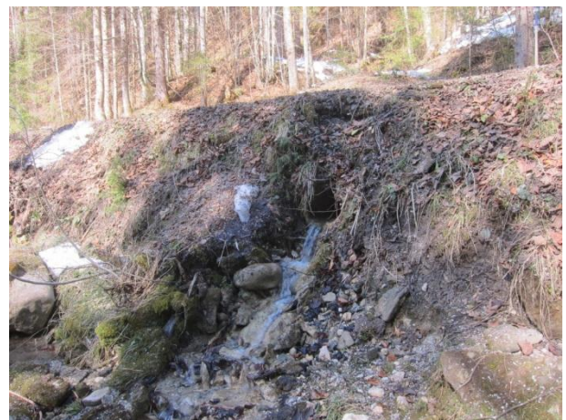
Abbildung 39: Eingeleitete Hangwässer mittels Betonverrohrung.
