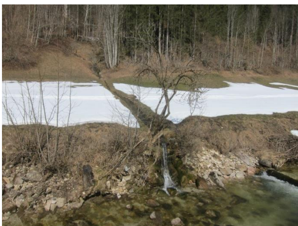
Abbildung 30: Entwässerungsgerinne orographisch rechts, Betonschalenausführung
