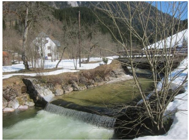
Abbildung 33: Geschiebesperre nicht passierbar.
