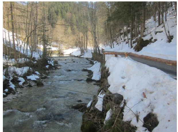
Abbildung 43: Längsverbauungen im Nahbereich der Begleitstraße erlauben keine natürliche Laufentwicklung in diesem Abschnitt.
