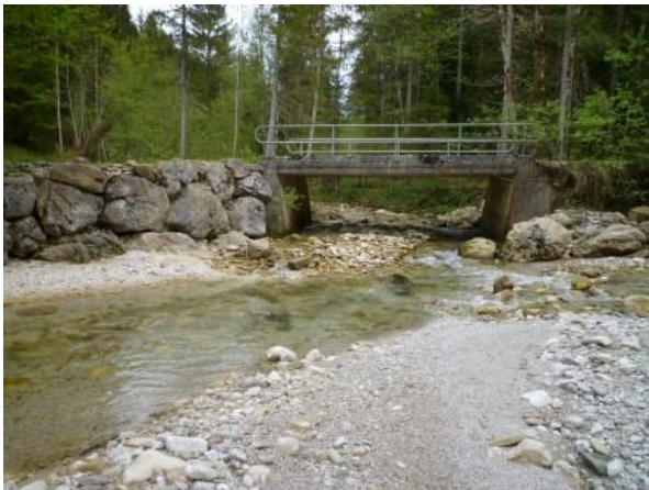
Abbildung 71: Weiteres Brückenbauwerk mit Uferverbauungen
