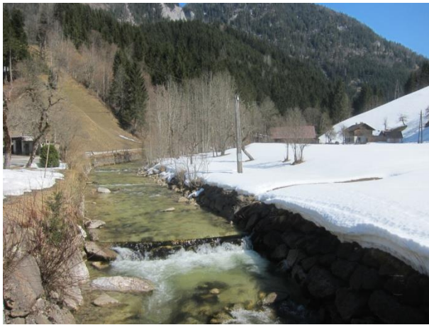
Abbildung 34: Ansicht Sohlgurtkette am Beginn des dritten Abschnittes, nicht passierbar.
