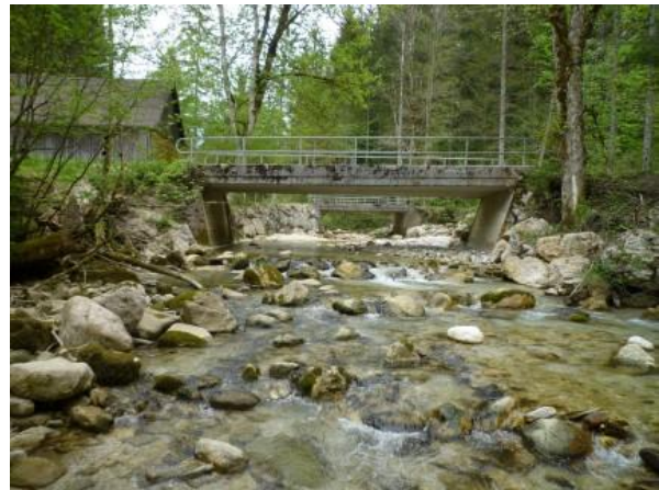
Abbildung 70: Brückenbauwerk mit beidseitigen Ufersicherungen
