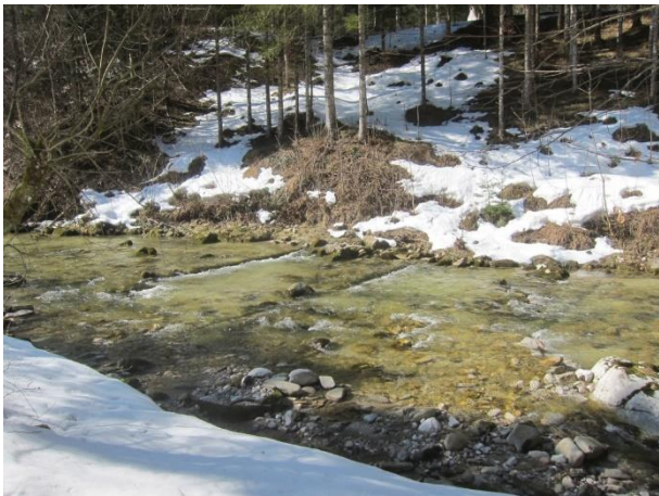
Abbildung 18: Passierbare Querverbauung mittels Holzstämmen stromauf der Brücke.
