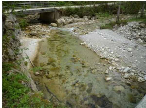
Abbildung 72: Strukturverarmung zwischen den Brückenbauwerken aufgrund von Ansandung
