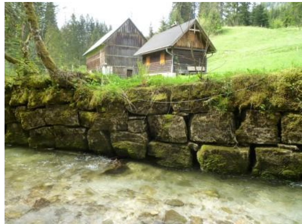
Abbildung 62: Detailsicht Hartverbauungen (Zyklopenmauerwerk) des orografisch rechten Ufers im Bereich der Jägeralm.
