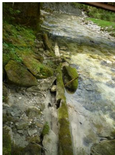
Abbildung 66: Reste einer Schußtafel zur Sicherungen gegen Auskolkung im Bereich der Brücke.
