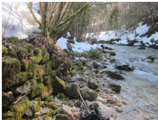
Abbildung 22: Längsverbauung mittels Steinschichtungen an landwirtschaftliche Fläche grenzend.
