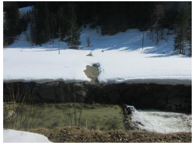
Abbildung 35: Fehlendes Ufergehölz und massive Uferlängsverbauungen am Beginn des dritten Abschnittes.
