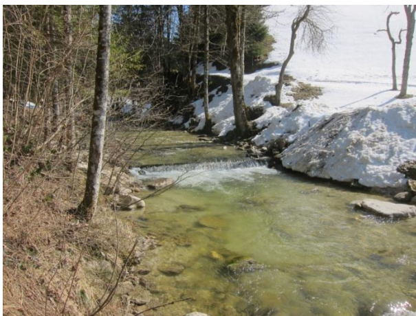
Abbildung 38: Sohlschwelle stromauf des Zubringers Sattelgraben.
