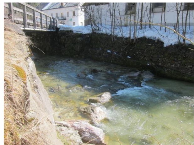
Abbildung 25: Sohlgurt aus Wasserbausteinen, passierbar. Ufermauern im Nahbereich der Brücke.
