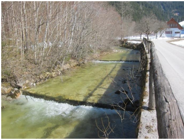
Abbildung 32: Sohlgurtkette über den gesamten Abschnitt 11.
