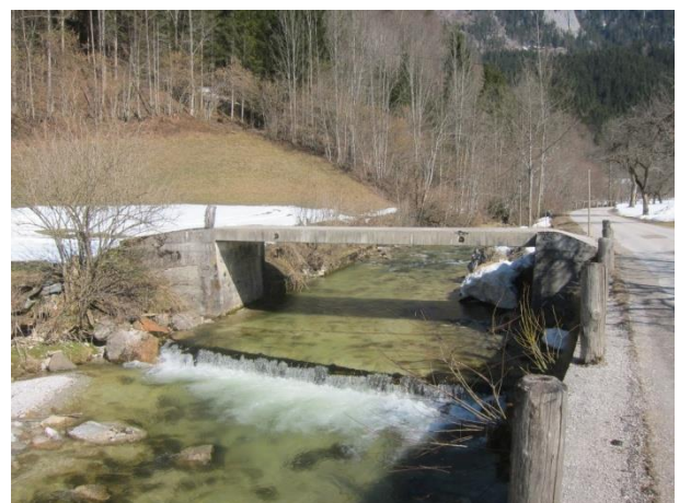
Abbildung 31: Querbauwerk nicht passierbar
