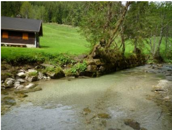
Abbildung 61: Hartverbauungen des orografisch rechten Ufers im Bereich der Jägeralm; Strukturverarmung im Gewässerbett erkennbar.
