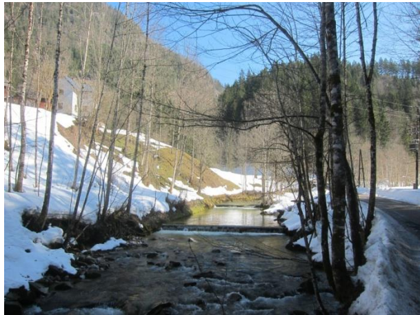
Abbildung 44: Querverbauungen im Bereich vor der Brücke Zubringer Abelgraben.
