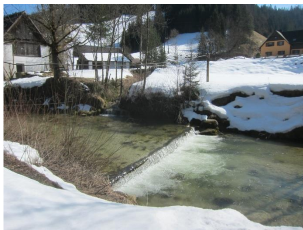
Abbildung 24: Querverbauung mit abgelösten Wasserstrahl, nicht passierbar.
