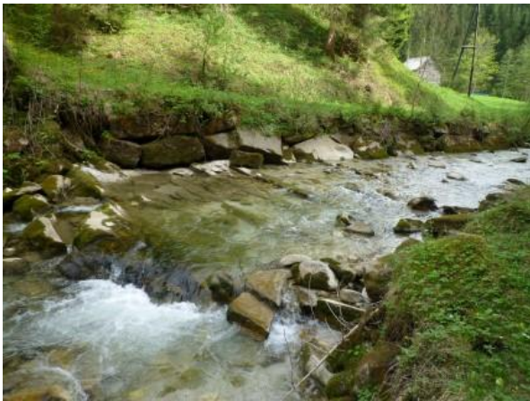
Abbildung 58: Grobsteinschichtung zur Ufersicherung im Bereich der Jägeralm.
