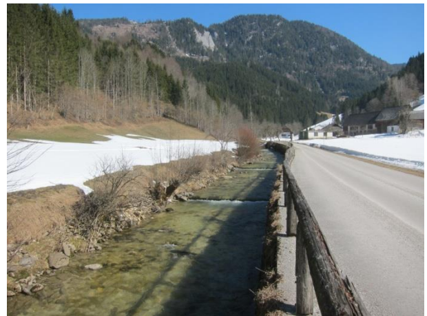
Abbildung 29: Ufergehölz fehlend in Abschnitt 11, eine Beschattung des Gewässers ist hier nicht gegeben.
