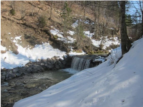
Abbildung 16: Querbauwerk des Flussbaus zur Sohlstabilisierung und Geschieberückhalt. Nicht passierbar für aquatische Lebewesen.
