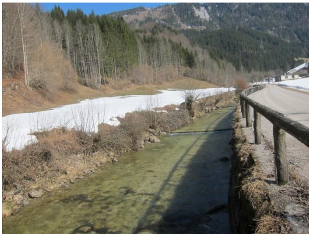
Abbildung 28: Quereinbauten zur Sohlstabilisierung
