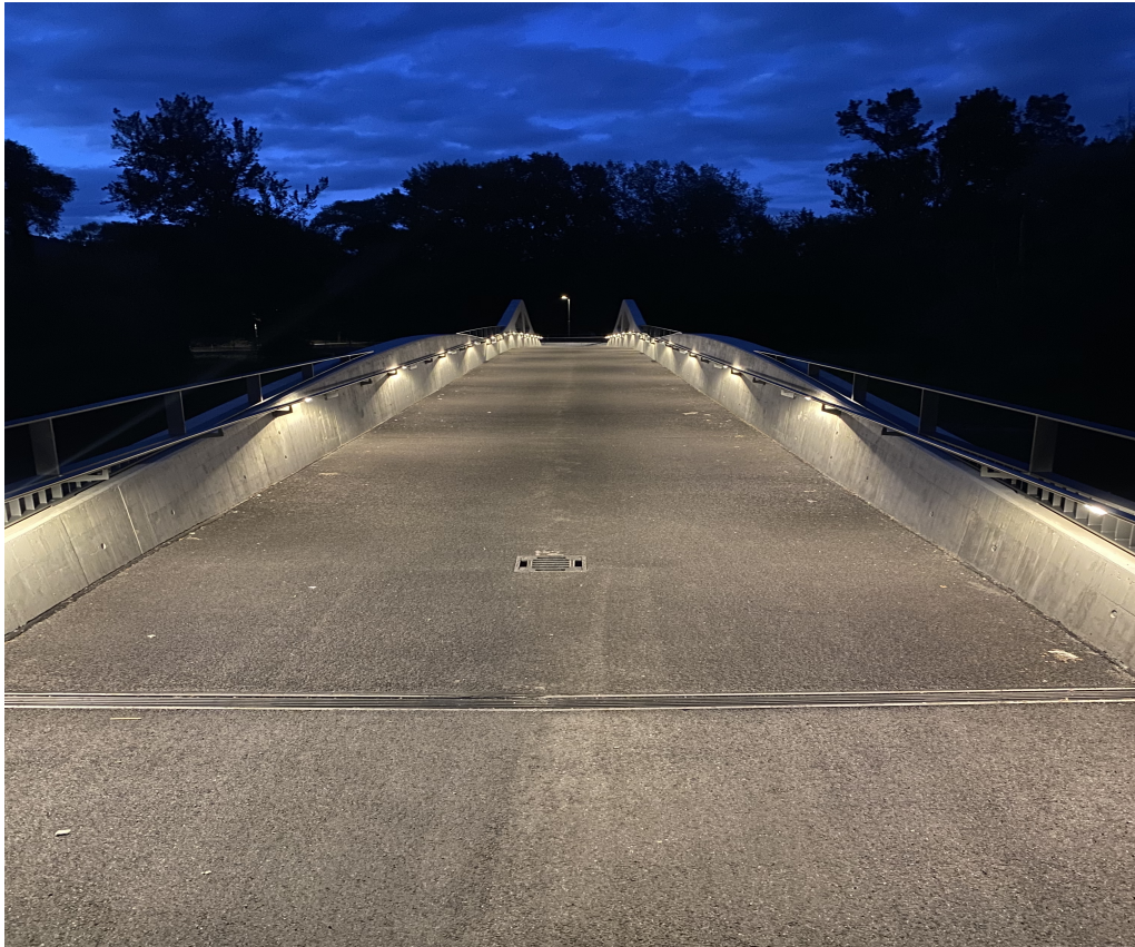
R2 Geh-Radwegbrücke Gratkorn-Gratwein
