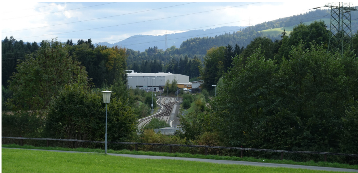
Abbildung 6: Fotostandpunkt Nr. 3. Blick Richtung Südwesten. Anschlussgleis des Standortes Leibenfeld an die GKB (Quelle: PLANUM, J. Leitner, 29.09.2015)
