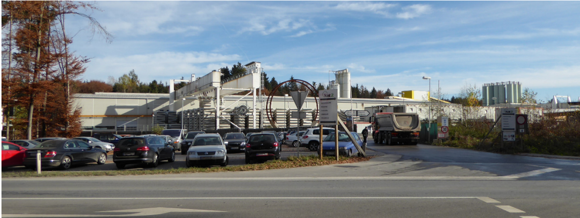
Abbildung 2: Fotostandpunkt Nr. 1. Blick Richtung Osten . Anbindung des Standortes Leibenfeld an die Landesstraße B76 (Quelle: PLANUM, D. Fleck, 20.11.2015)
