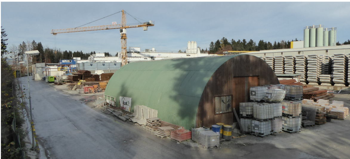
Abbildung 3: Fotostandpunkt Nr. 2. Blick Richtung Norden . ÖBB-Baustelleneinrichtung „Zwischenangriff Leibenfeld“ (Quelle: PLANUM, D. Fleck, 20.11.2015)
