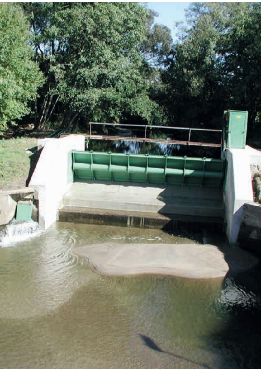
Abb. 5: Querbauwerke fragmentieren die Lafnitz - Großschemlmühle bei Markt Allhau. © G. Wolfram
