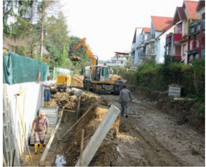
Abb. 4: Die Arbeiten waren unter beengten Verhältnissen durchzuführen. © A10/5
