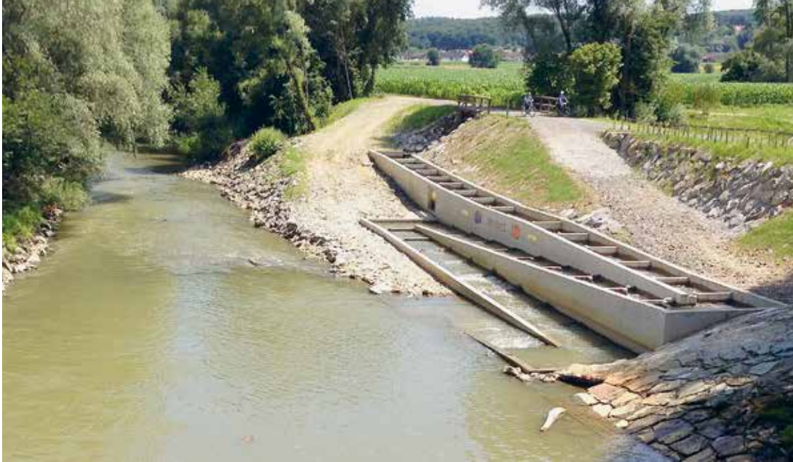
Abb. 1: Mittels Fischaufstiegshilfen (Typ Schlitzpass in seiner gesamten Größe) soll eine Wiederherstellung der Durchgängigkeit an den Wehranlagen erfolgen.
