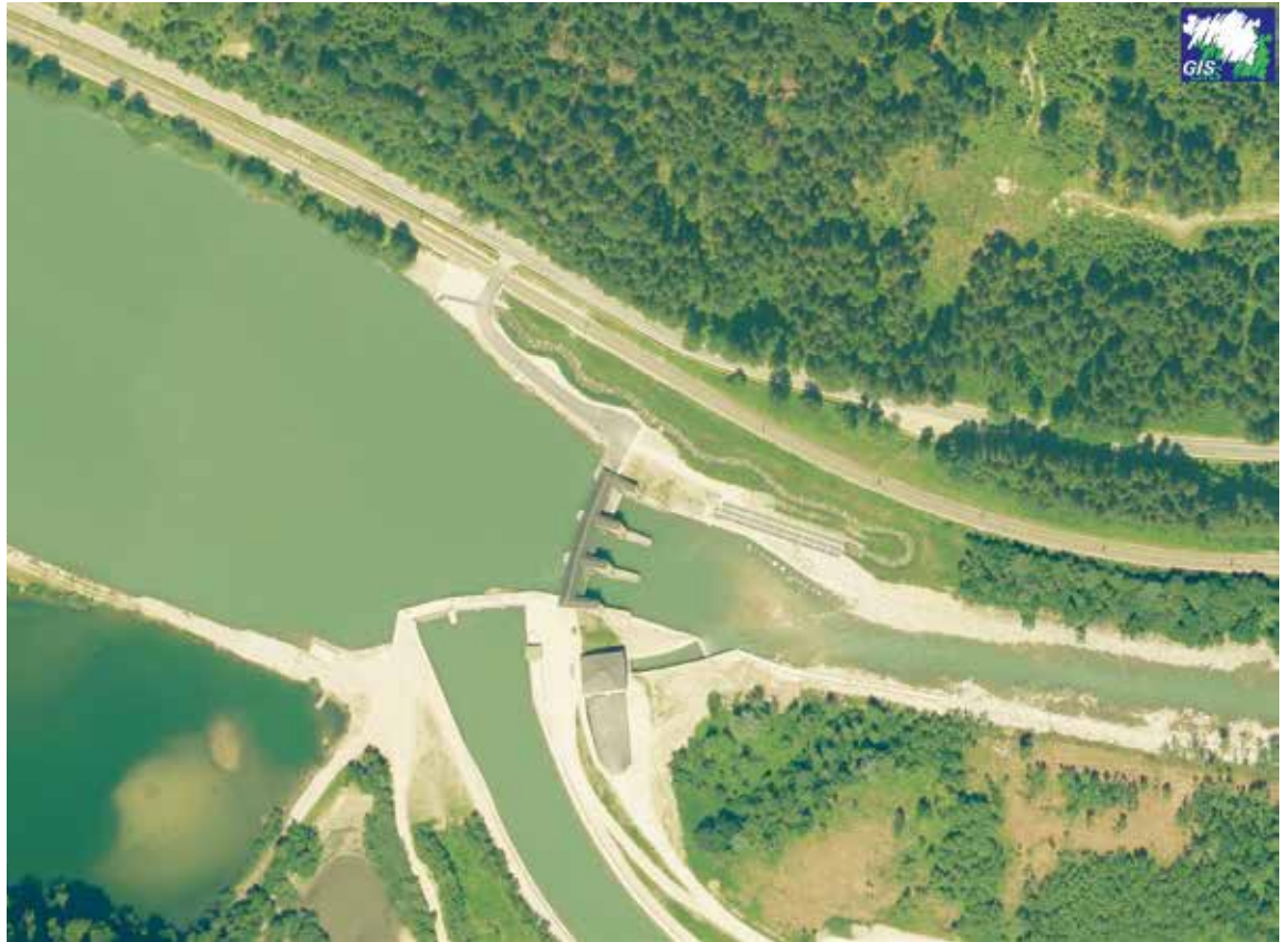
Abb. 6: Luftaufnahme vom Kraftwerk Hieflau mit Fischaufstieg, Restwasserstrecke und Stauraum
