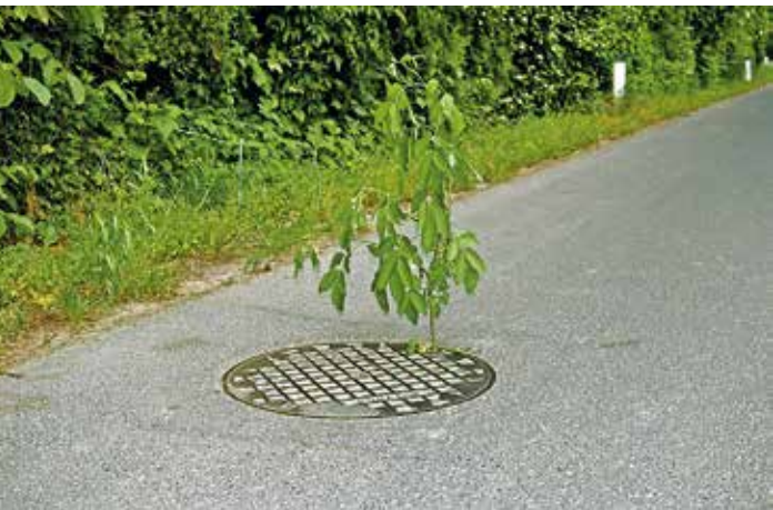
Abb. 3: Unter der Erde befindet sich oft Unerwartetes
