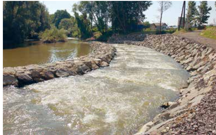
Abb. 8: Raab: Fischaufstieg Ertlermühle nach Fertigstellung
