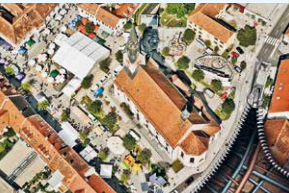
Unterirdisches Leitungsnetz – unsichtbar und wertvoll © Initiative VOR SORGEN
