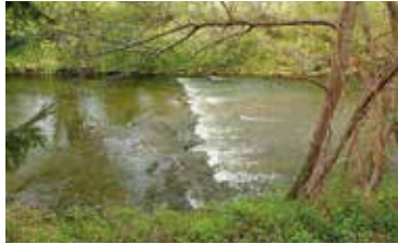
Abb. 3: Kainach: Sohlstufe 15 vor Umbau
