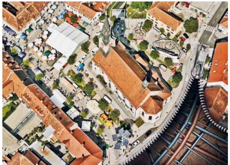
Abb. 1: Unterirdisches Leitungsnetz – unsichtbar und wertvoll © Initiative VOR SORGEN
