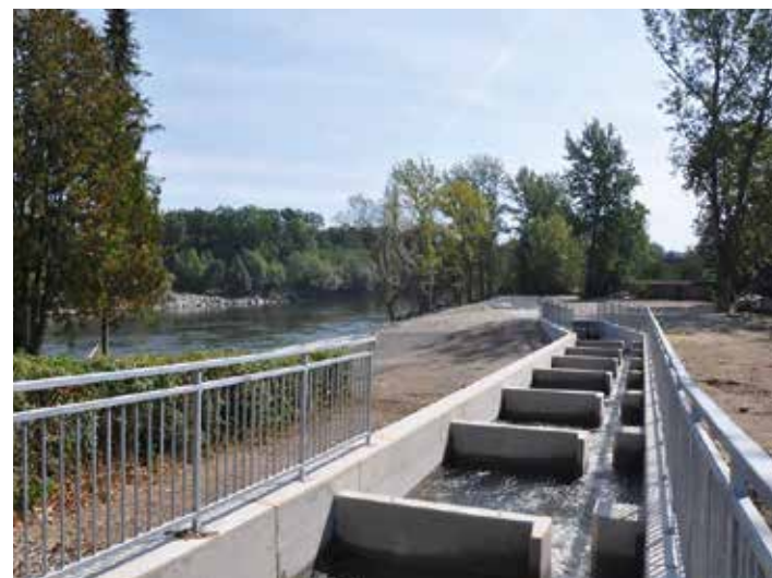
Abb. 9: Fischaufstieg bei Murkraftwerk Gralla nach Fertigstellung
