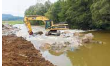
Abb. 4: Kainach: Sohlstufe 22 im Zustand des Baues
