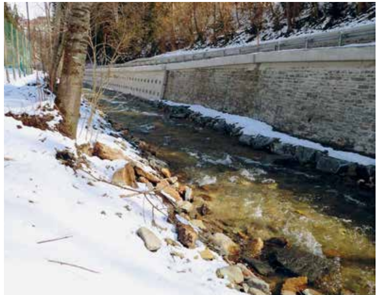
Abb. 1: Massive Ufersicherungsmaßnahmen ; Bereich Landstraße Waldbach
