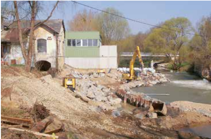
Abb. 7: Raab: Umbauarbeiten bei Ertlermühle
