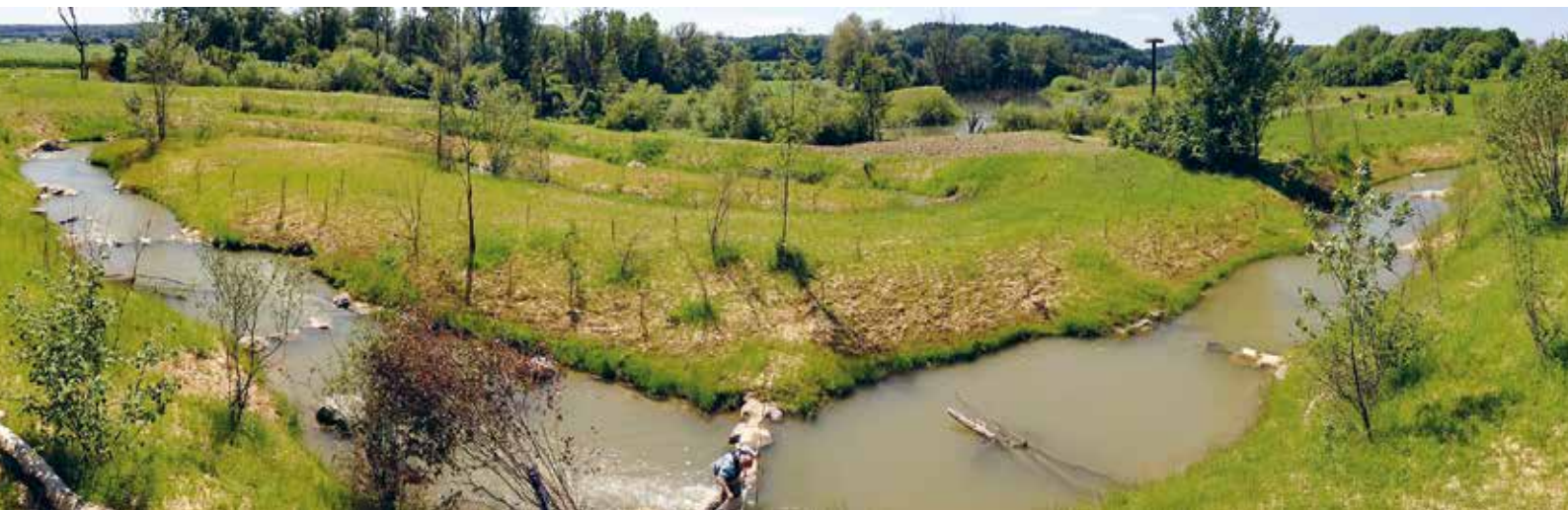
Abb. 3: Das rund 330 m lange Umgehungsgerinne beim Kraftwerk Hohenbrugg dient der Fischpassierbarkeit und auch als neuer Lebensraum. Copyright: IB Parthl
