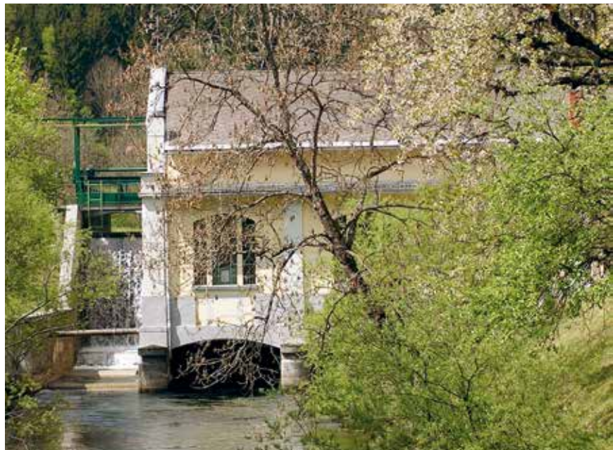
Abb. 1: Kraftwerk Kohlleben, 1906 in Betrieb genommen
