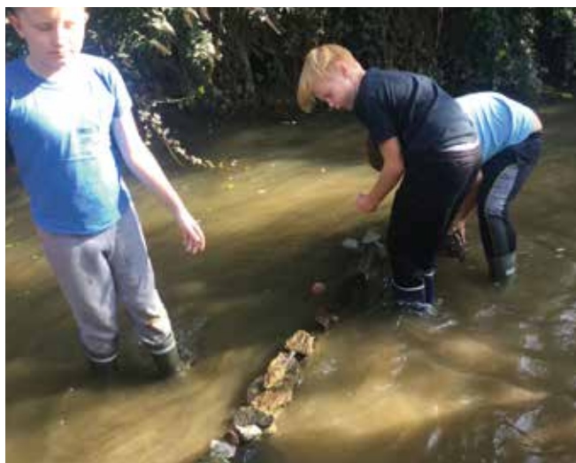
Abb. 2: Bei der Errichtung der „Querbauwerke“ © UBZ Stmk.
