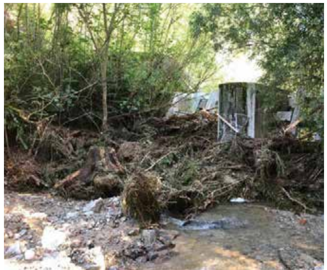
Abb. 7: Verfüllte Geschiebesperre am Zeilerbach bei hm 1,40 © WLV
