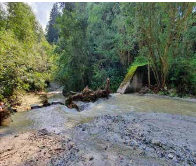
Abb. 6: Verfüllte Geschiebesperre, Hirschbach bei hm 35,70 © WLV
