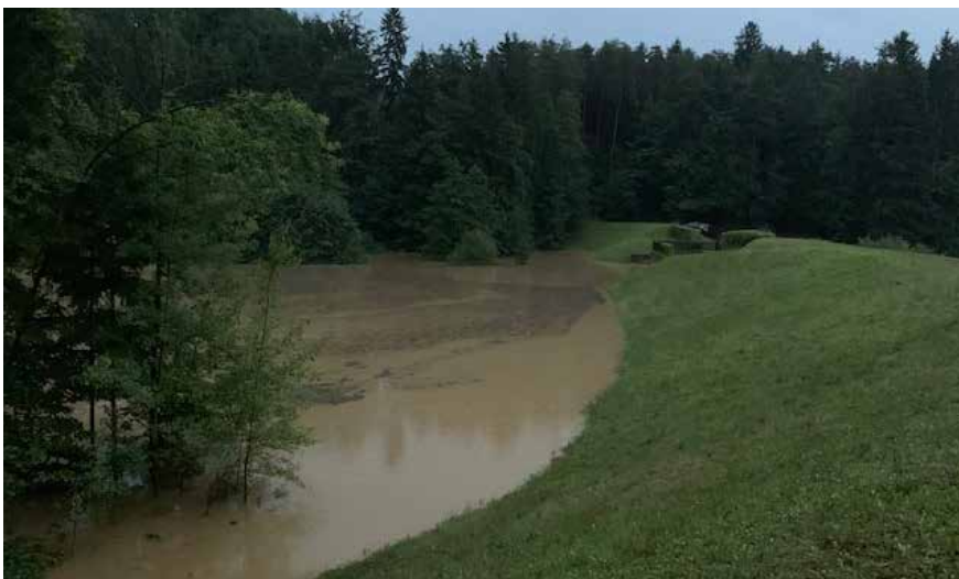
Abb. 3: Eingestautes Rückhaltebecken Oberbergbach © BWV
