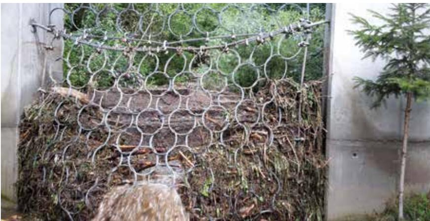
Abb. 4: Geschieberückhalt durch Verbauung konnte Schäden im Höllgraben verhindern © WLV
