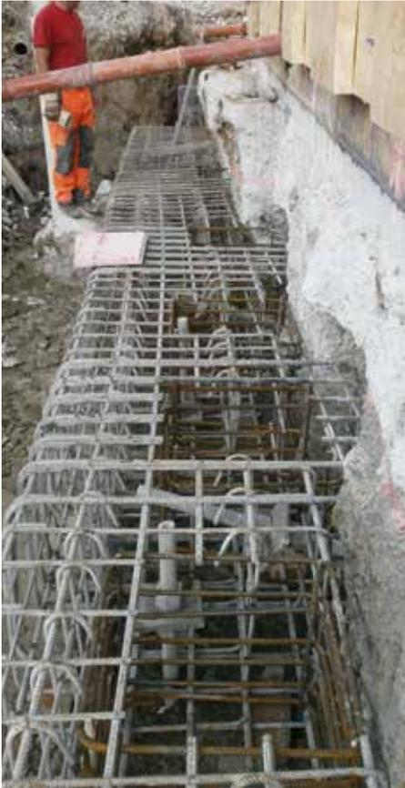
Abb. 6: Stahlbetonriegel und Bewehrungskörbe, die über Einschmätzungen kraftschlüssig mit dem Bestandsfundament verbunden wurden. Auch erkennbar sind die vertikalen Druckpfähle und die schrägen Zugpfähle.
