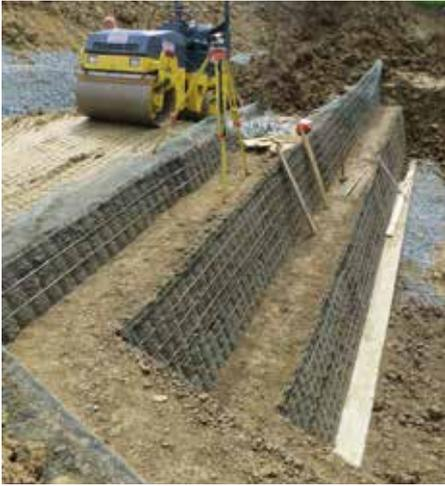
Abb. 5: Hangsicherung mittels Polsterdamm (mit verlorder Schalung) bei der Böschung oberhalb des EFH Starz.
