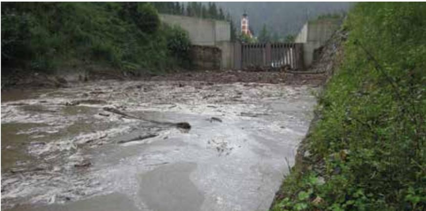
Abb. 3: Schäden im Ortsgebiet von Winklern konnten durch eine Geschiebesperre verhindert werden © WLV
