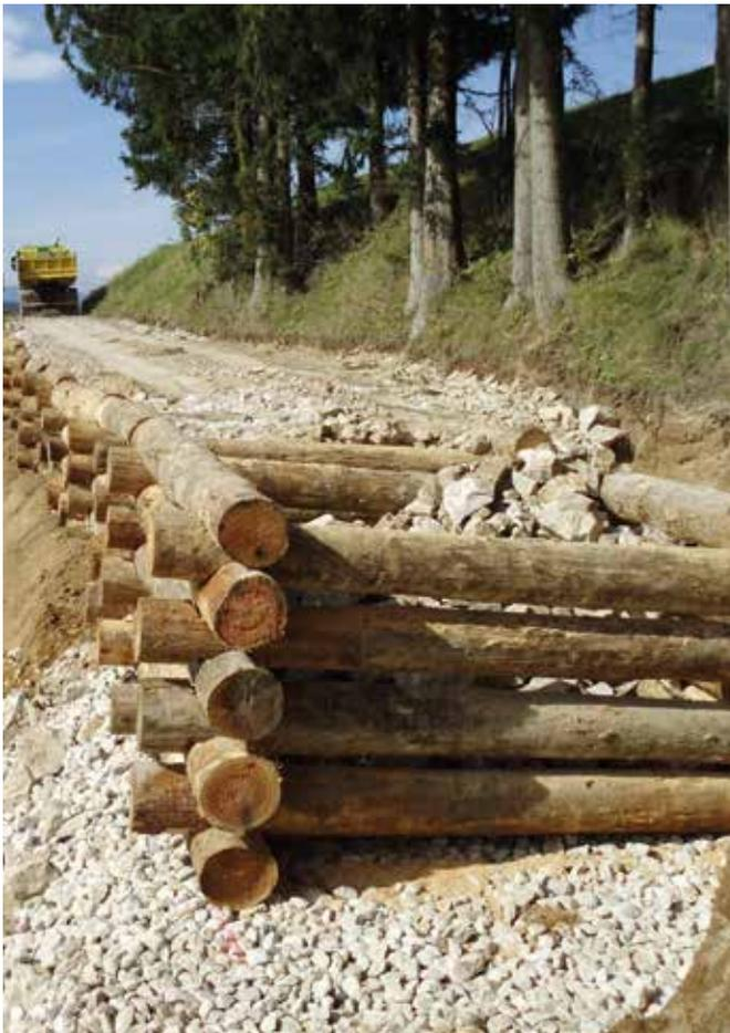
Abb. 8: Krainerwand zur Stabilisierung des abgerutschten Unterhanges in Amering, Obdach. Die Krainerwand dient zugleich auch als Unterbau für den Weg.
