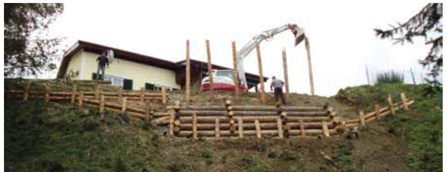
Abb. 9: Krainerwand zur Stabilisierung des Hanges unterhalb eines Wohnhauses. Zusätzlich wurden Holzpfähle zur Fixierung der Krainerwand selbst und von Holzquerverbauungen eingebracht.
