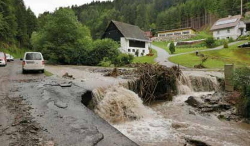
Abb. 8: Am Naintschbach verursachten Starkniederschläge Brückenverklousungen und massive Schäden an der Infrastruktur © WLV
