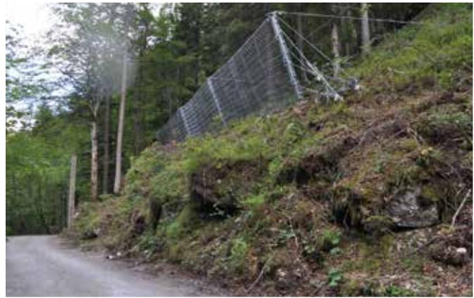
Abb. 10: Dynamische Steinschlagnetze zum Schutz des stark frequentierten Weges
