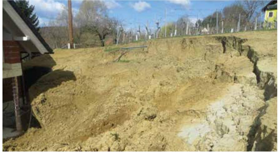
Abb. 4: Blick auf den etwa 25 m langen, sichelförmigen Anriss oberhalb des Einfamilienhauses Starz.
