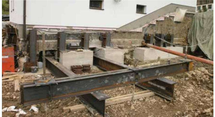
Abb. 7: Vorrichtung für die Hebung des Gebäudes. Horizontale Stahlträger, die bis unter das Fundament reichen und auf die die Pressen (blaue Presse beim linken Träger erkennbar) gestellt werden. Diese wurden am anderen Ende der Träger über vertikale Stahlträger mittels Zugpfählen fixiert. Die vertikalen Stahlträger entlang des Hauses verhinderten ein Verkippen des Gebäudes beim Anheben.
