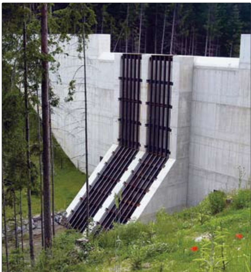
Abb. 2: Waisenbach, Gemeinde Birkfeld, Hochwasser-Rückhaltebecken
