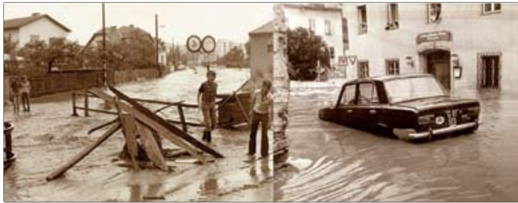
Abb. 6: Hochwasser 1975: links: Mariatrosterbach; Kirchbergstraße (Anstieg zur Mariatroster Basilika); rechts: Schöckelbach; Brücke Schöckelbachweg – Andritzer Reichsstraße, knapp vor der Andritzer Maut. (Foto: Zwittnig)
