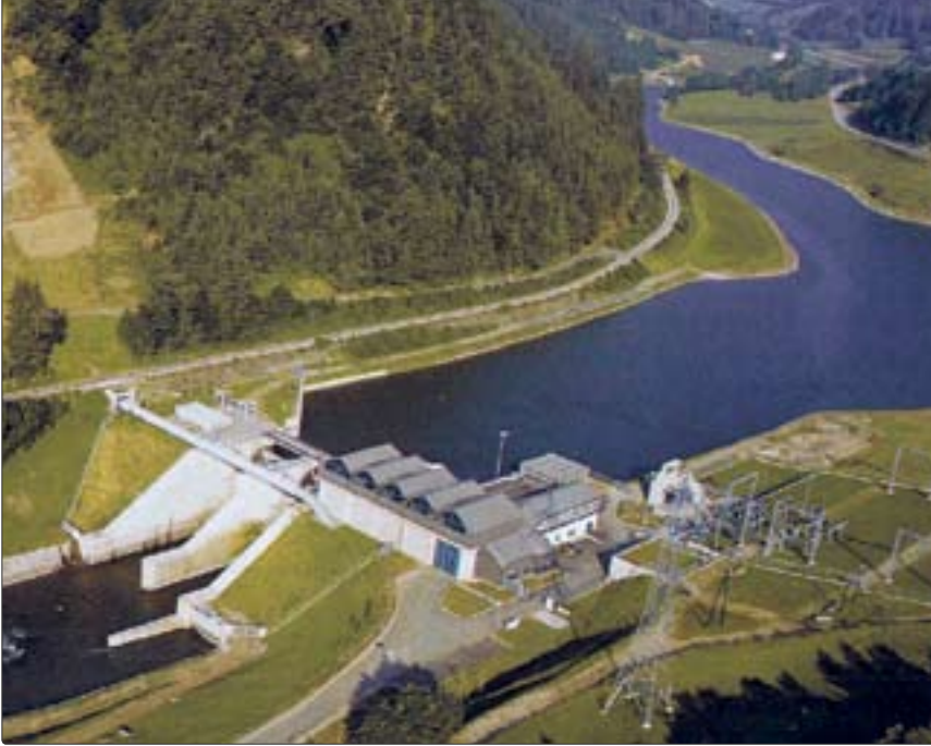
Abb. 2: Das Kraftwerk Bodendorf
