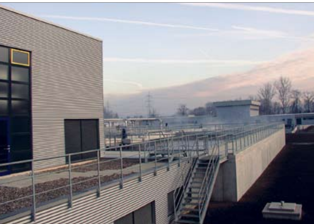
Abb. 10: Maschinenhaus mit Biologie neu
