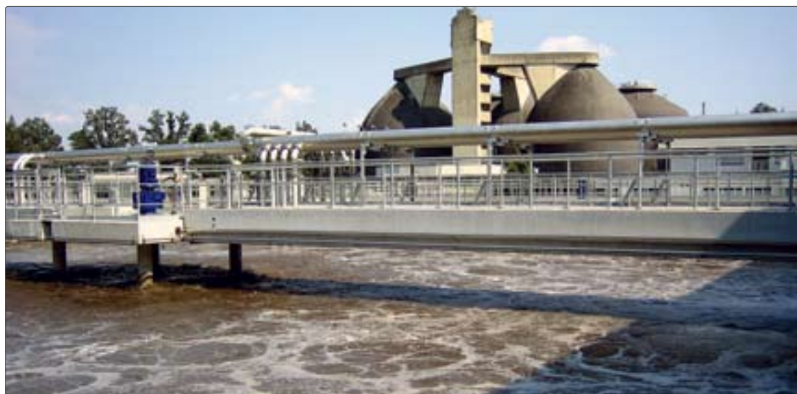
Abb. 1: Belebungsbecken neu, im Hintergrund die Faultürme
