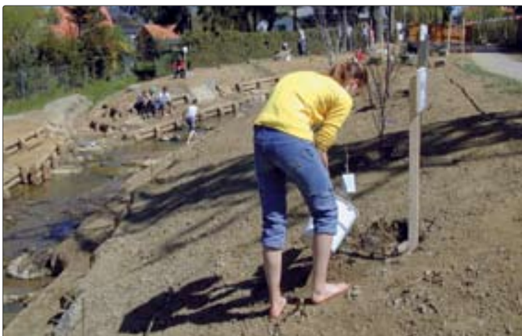
Abb. 10: Petersbach; gemeinsames Projekt (Restrukturierung eines hart verbauten Bachabschnittes) mit der Öko-Tech-Hauptschule Graz-St. Peter („Bachpatenschaft“)
