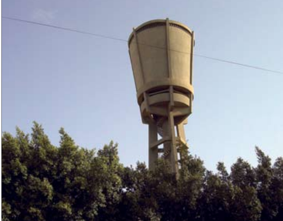
Abb. 4: Wasserturm als Trinkwasser- reservoir
