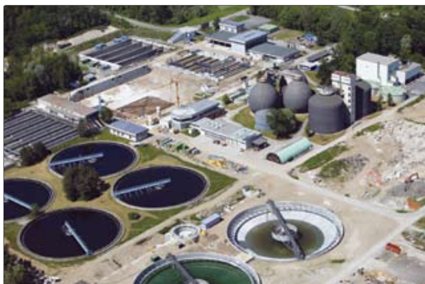
Abb. 3: Luftbild während der Umbauarbeiten 2005 (Foto Schiffer)
