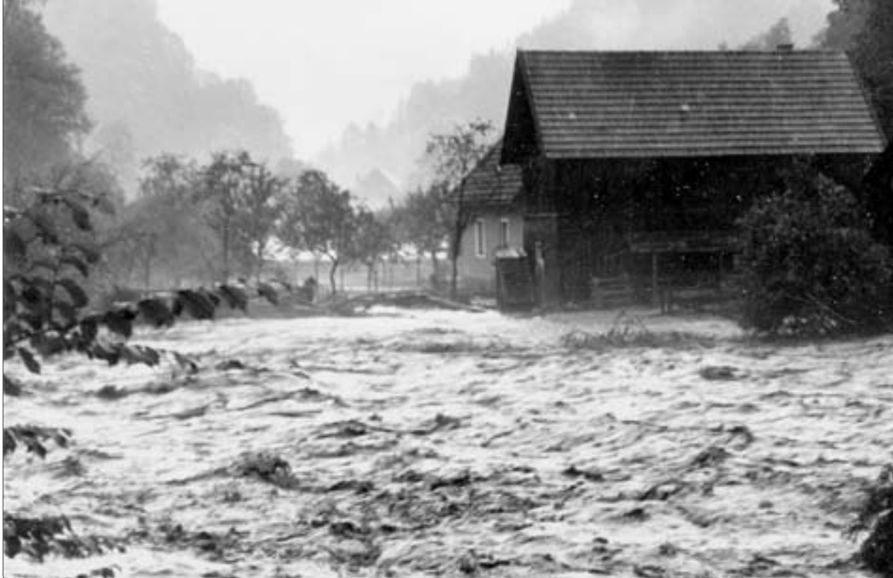
Abb. 3: Gamsbach, Gemeinde Gams bei Hieflau, Hochwasser 1961 (SW-Bild)
