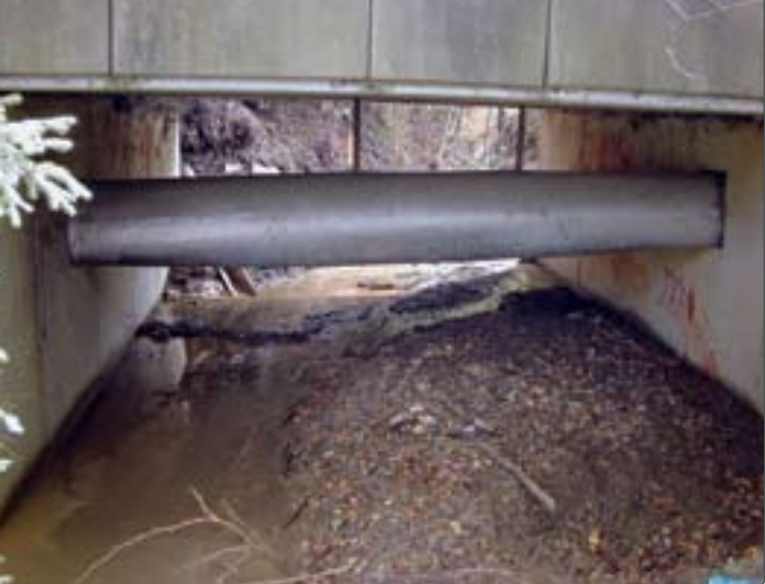
Abb. 2: Weizbach; „verklausungsanfälliges“ Brückenlicht-raumprofil (Franz Werfel-Weg)
