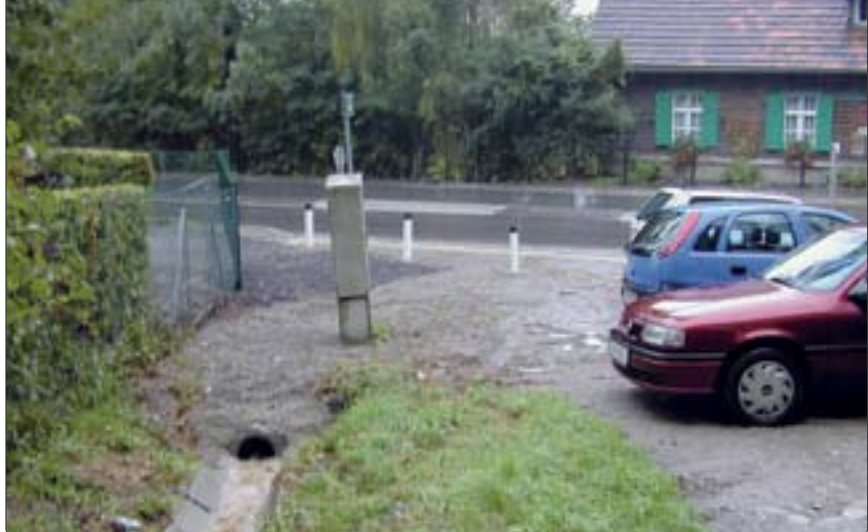
Abb. 3: Falkenbach; das Ende der freien, offenen Fließstrecke (Betonrohr DN300; HQ_{100} = 6\text{m}^3/\text{s} )
