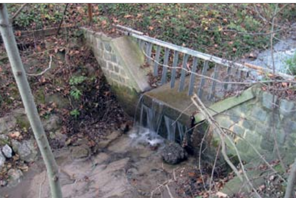
Abb. 4: Stufenbach; ein Absturzbauwerk als Grundgrenze
