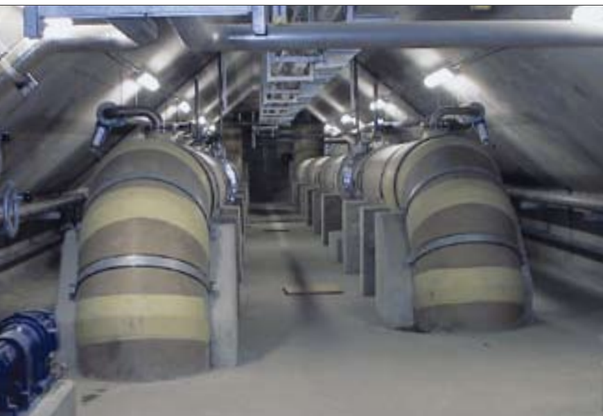
Abb. 6: Blick unter die belüfteten Sandfänge
