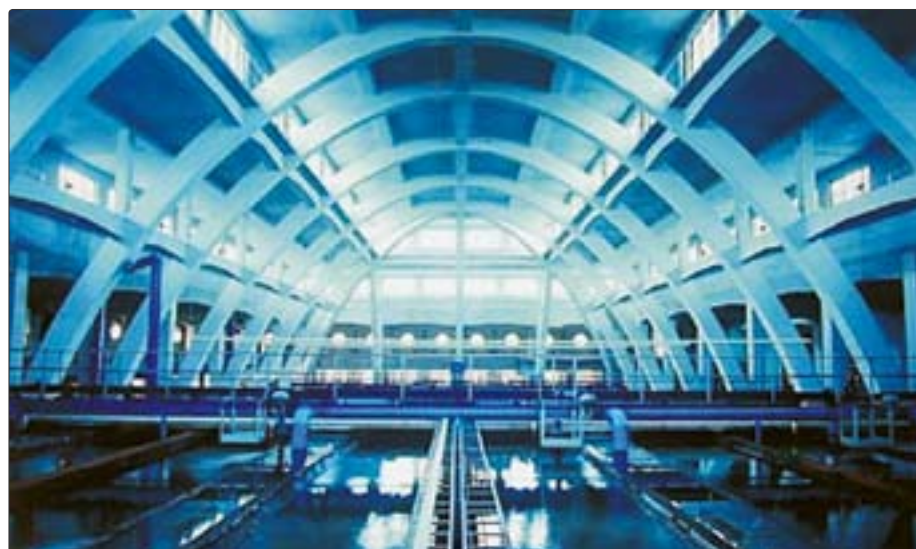
Abb. 4: Wasseraufbereitungsanlage in Prag, Podoli
