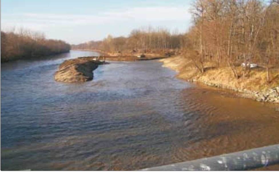
Abb. 8: Aufweitung der Mur in Donnersdorf (Geschiebedotation). Aufweitung der Mur und Vernetzung mit einem Zubringer inklusive Geschiebedotation dienen der Gewässervernetzung und der Sohlstabilisierung entsprechend dem Grundsatzkonzept für die Grenzmuir.
