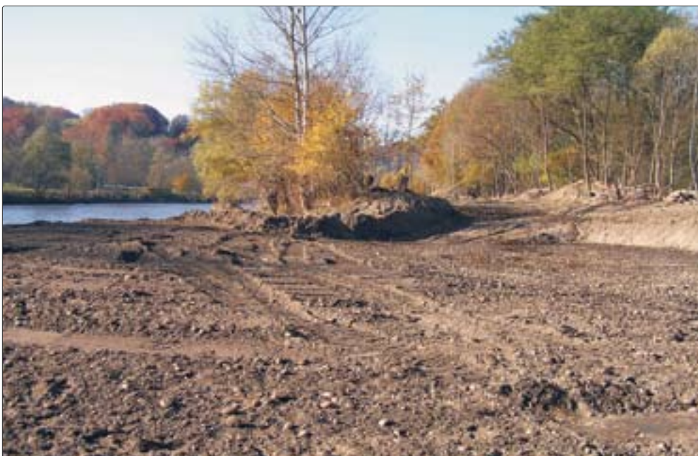
Abb. 7: Aufweitung der Mur in Weitersfeld (Bauphase). Auch hier wurde durch die Anlage eines Hinterriners und die Dotation des anfallenden Materials sowohl wasserbaulichen als auch ökologischen Zielen entsprochen.
