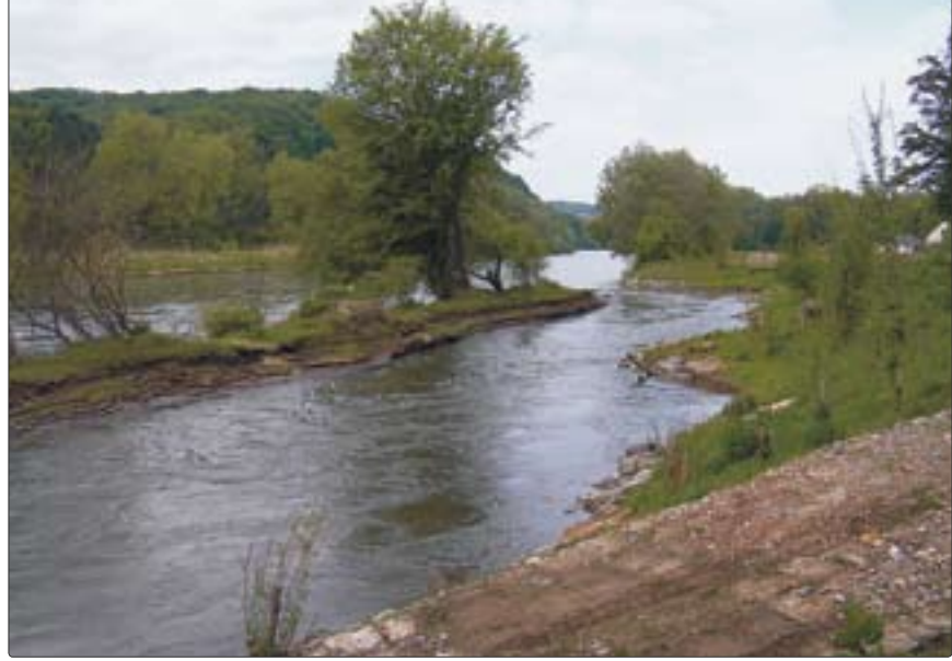
Abb. 6: Aufweitung an der Mur in Oberschwarza
