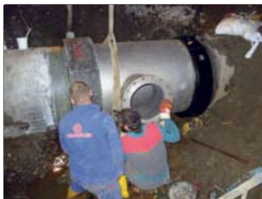
Abb. 3: Bau der Transportleitung in der 2. Plabutschröhre (2004)
