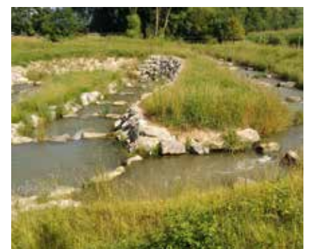
Abb. 4: Fischaufstieg am KW Clement an der Raab © A14
