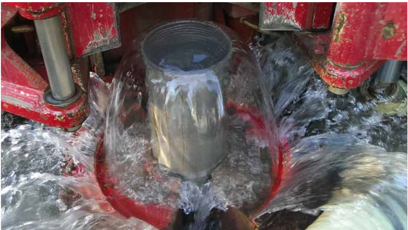
Abb. 1: Erschließung von hochwertigem Tiefengrundwasser für die Trinkwasserversorgung © A14/Ferstl
