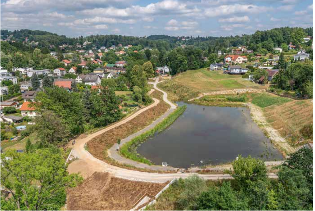
Abb. 3: Rückhaltebecken Petersbach © Picfly
