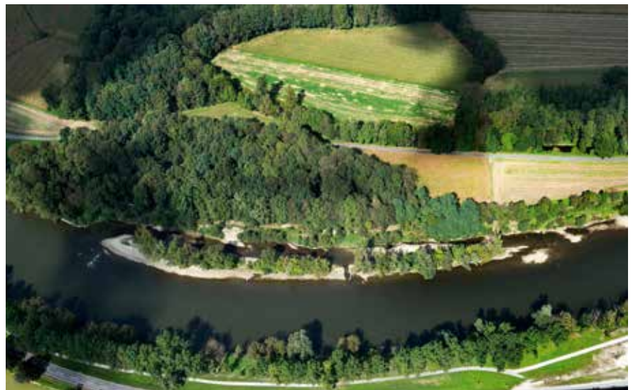
Abb. 2: Aufweitung Weitersfeld © Bundeswasserbauverwaltung Steiermark und zepp-cam/Graz
