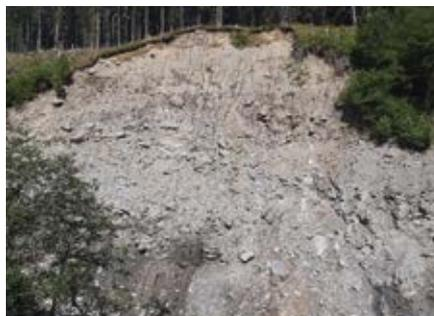
Abb. 18: Instabile Einhänge in der Schluchtstrecke hm 15 – 19 © WLV Sektion Steiermark
