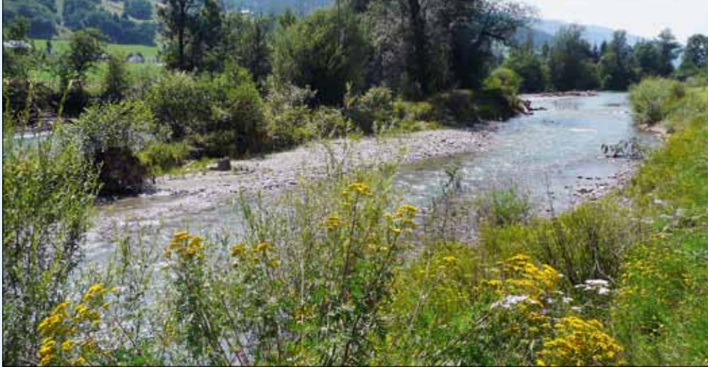
Abb. 7: Ennsaufweitung bei Haus im Ennstal: Ausbildung eines Seitennarmes mit Flachwasserzonen, Schotterbänken und Inseln
