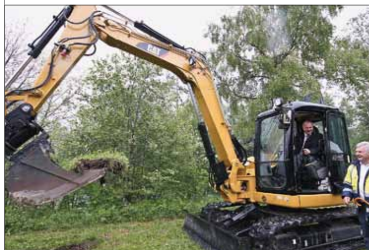
Abb. 6: Beim „Spatenstich“ für „Mehr Enns“ war „großes Gerät“ im Einsatz
