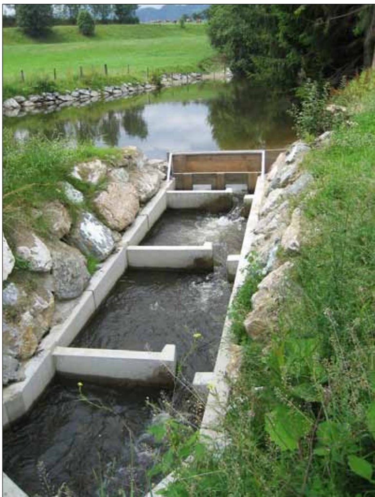
Vorrangige Sanierungsmaßnahme ist die Herstellung der Fischpassierbarkeit bei Querbauwerken.
