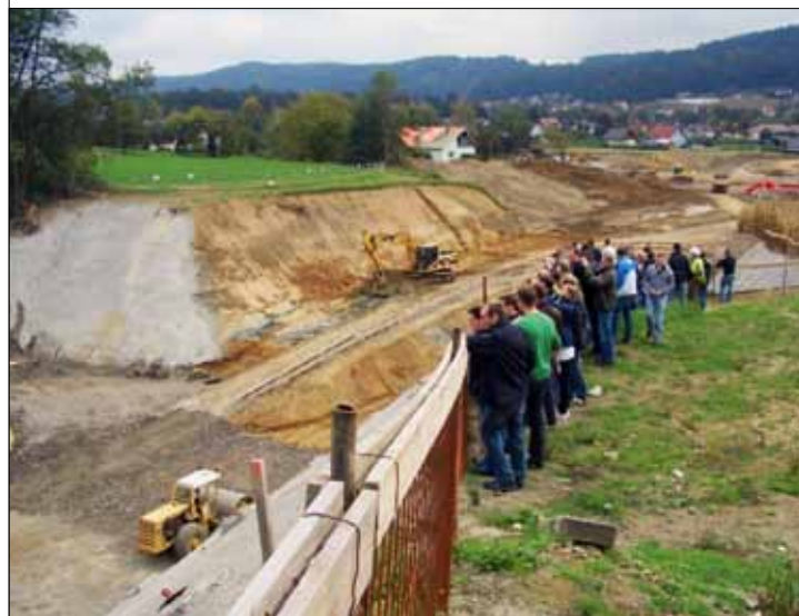
Abb. 1c: Tunnelbaustelle Umfahrung Hausmannstätten, Südportal
