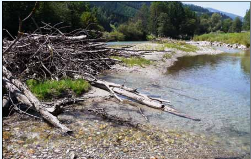
Abb. 8: Ennsaufweitung bei Pruggern: Ausbildung eines strömungsberuhigten Seitengerinnes mit Treibholzansammlung
