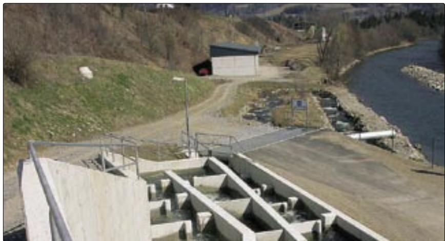
Abb. 1: Im Vordergrund der technische Schlitzpass, im Hintergrund der natürliche Beckenpass.
