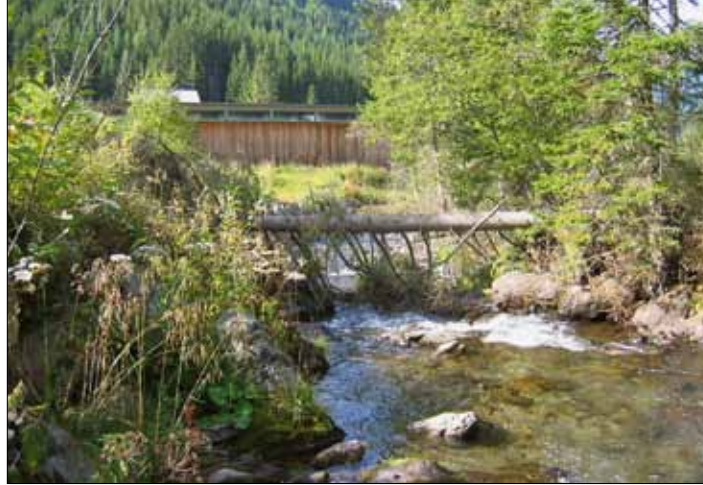
Abb. 2: Querende Baumstämme verursachen Verkläuerungen und hemmen den Wasserablauf bei Hochwasser
