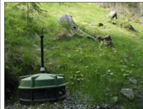
Abb. 3: Geschlossener Quellsammelschacht für Kleinwasserversorger
