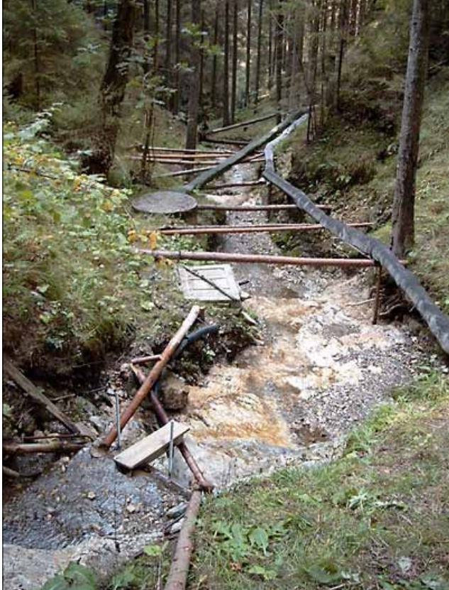
Abb. 6: Übelstände an Wildbächen sind zu beseitigen
