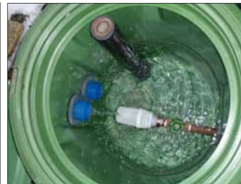
Abb. 1: Quellsammelschacht
