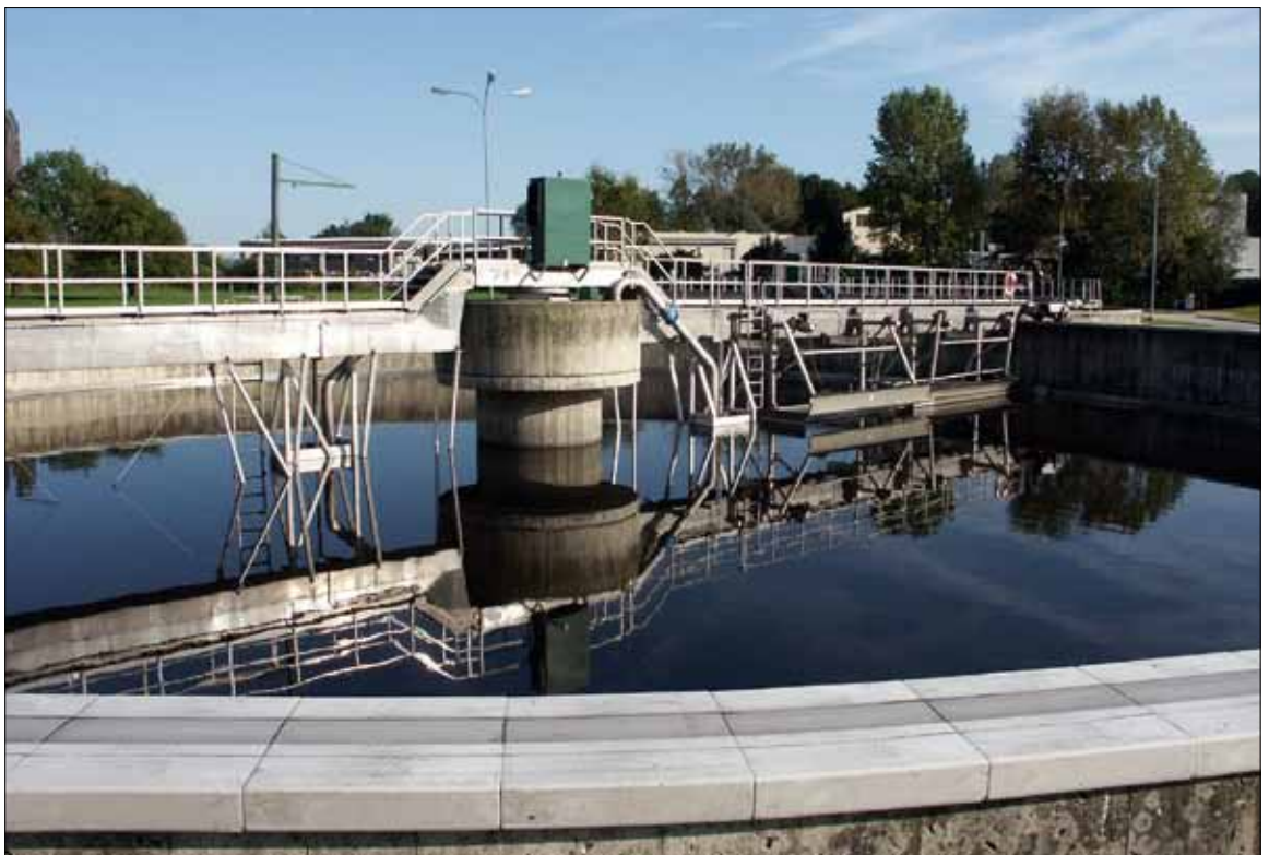
Abb. 1: Abwässer werden in Kläranlagen auf aktuellstem Stand der Technik gereinigt
