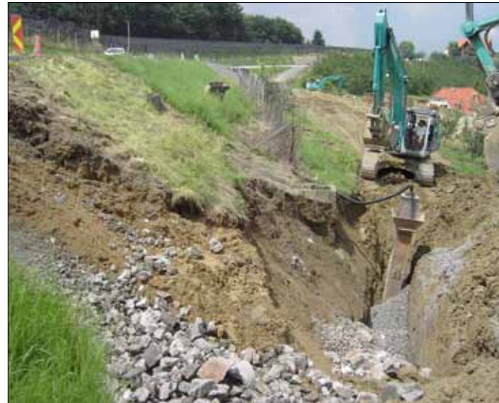
Abb. 5: Sanierung der Hangrutschung in der Gemeinde Riegersburg
