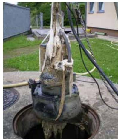
Abb. 1: Verstopfte Pumpe im Zulauf-Pumpwerk Leutschach © Franz Hammer
