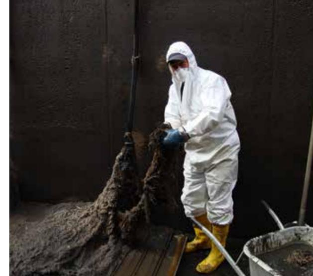
Abb. 3: Enorme Verzapfungen im Belebungsbecken der Kläranlage Radiga © Franz Hammer
