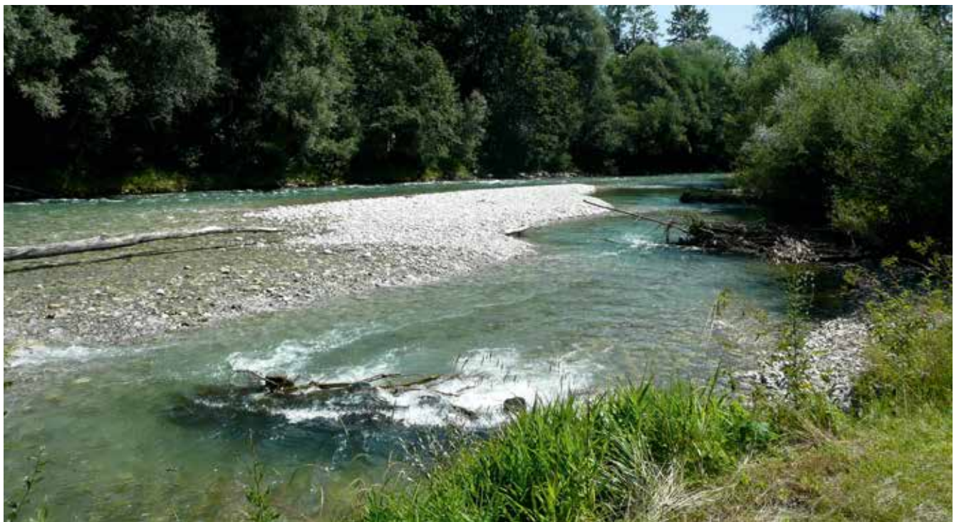
Abb. 6: Schutz des Ufers in einer Aufweitung durch inklinante Holzbuhen an der Enns. © A14
