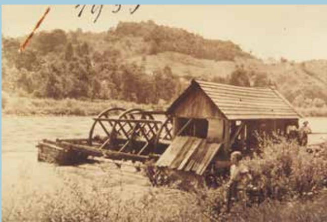
Die letzte in Betrieb befindliche steirische Schiffmühle im Raum Mureck, aufgenommen etwa im Jahr 1939. © Sammlung Reismann
