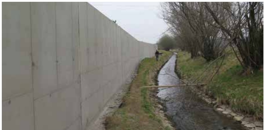
Abb. 5: Hochwasserschutzmauer zwischen Liebochbach und Bachfeldgasse © Daninger & Partner ZT KG
