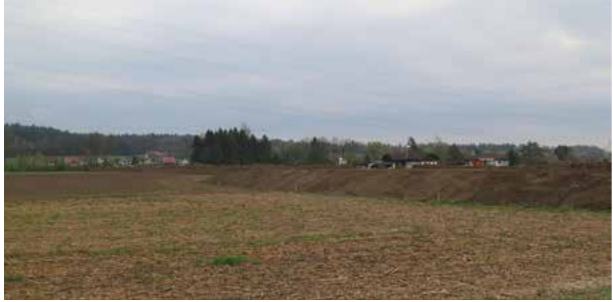
Abb. 3: Ansicht Hochwasserschutzdamm wasserseitig © Daninger & Partner ZT KG
