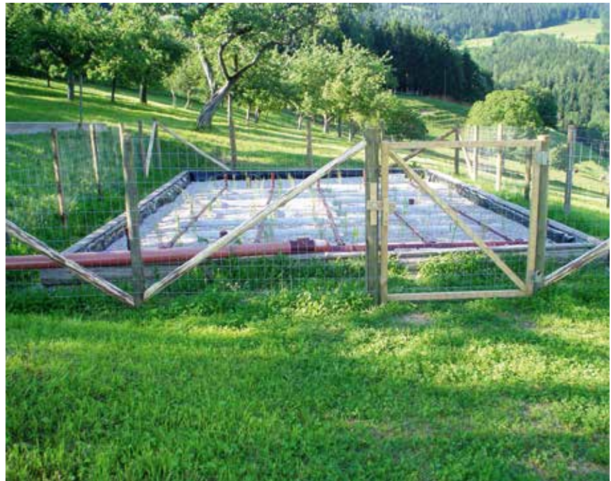
Abb. 3: Bepflanzte Bodenfilter – Pflanzenkläranlagen reinigen häusliche Abwässer © Ökologisches Projekt Graz
