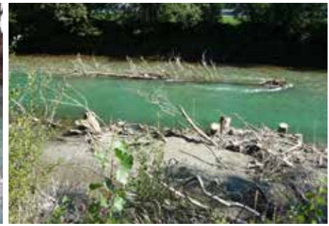
Abb. 4 und 5: Im Zuge des LIFE+-Projektes an der Enns wurde 2011 eine ganze Fichte als Strukturbildner im Flussbett mit langen Piloten verankert. 4 Jahre später ist der Baum immer noch vorhanden und es haben sich deutliche Flach- und Tiefwasserbereiche gebildet. © A14
