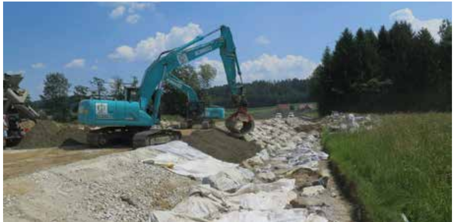
Abb. 4: Dammfuß luftseitig im Bereich der Hochwasserentlastung © Daninger & Partner ZT KG
