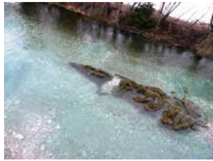
Abb. 4 und 5: Im Zuge des LIFE+-Projektes an der Enns wurde 2011 eine ganze Fichte als Strukturbildner im Flussbett mit langen Piloten verankert. 4 Jahre später ist der Baum immer noch vorhanden und es haben sich deutliche Flach- und Tiefwasserbereiche gebildet. © A14
