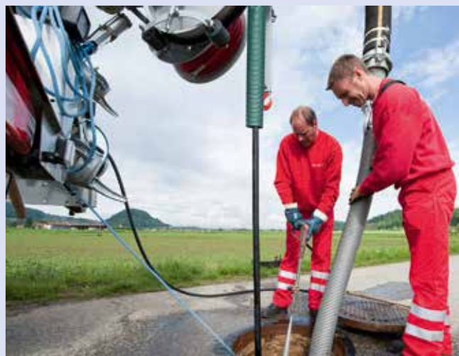
Mit einem Hochdruckspülschlauch wird Wasser in den Kanal gepumpt. Dabei lösen die Wasserstrahlen die Ablagerungen von der Rohrwand und befördern das Räumgut nach außen, wo es von einem Saugschlauch abgesaugt wird.
