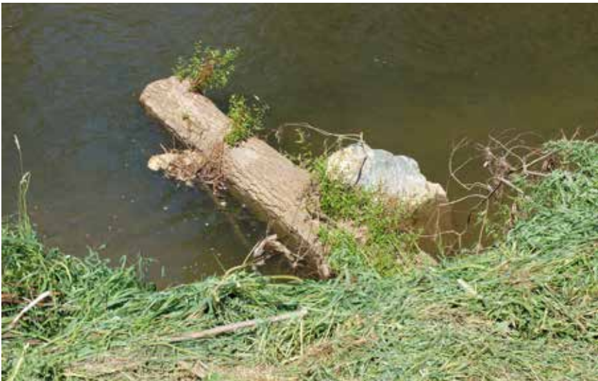
Abb. 3: Ein mit Wurzelteller in der Böschung verankerter Weidenstamm lenkt die Strömung, schafft Tiefstellen und treibt neu aus. © A14
