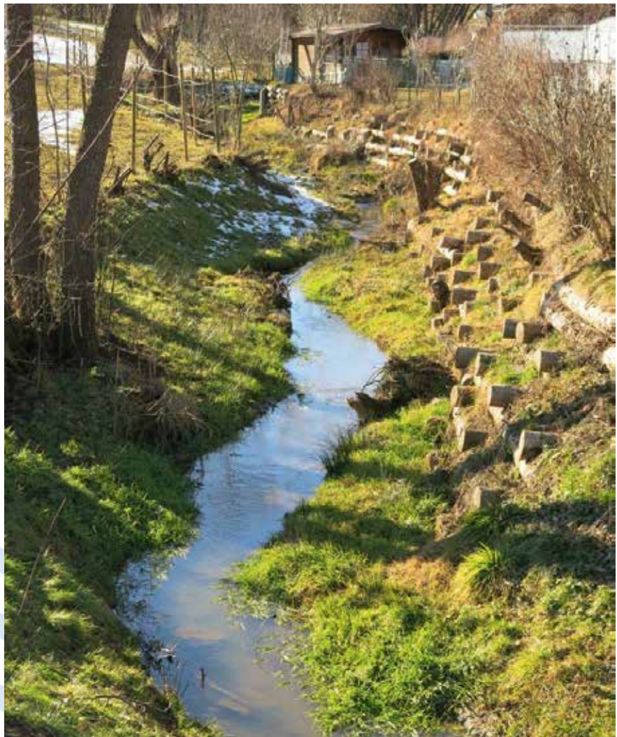
Hochwasserschutz: Linearmaßnahme am Erlenbach © Marktgemeinde Thal
