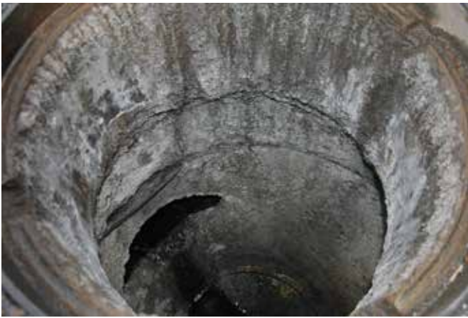
Schäden in Kanal- und Klärsystemen aufgrund von biogener Schwefelsäure-Korrosion © TU Graz
