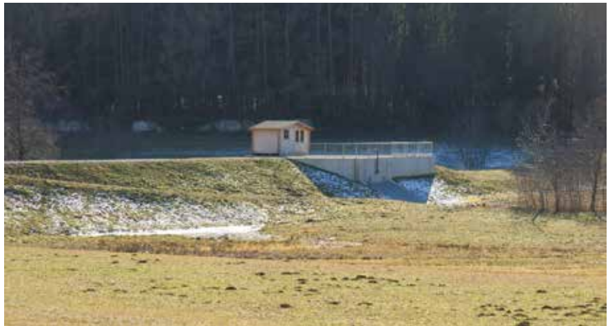
Hochwasserschutz: Rückhaltebecken am Erlenbach © Marktgemeinde Thal
