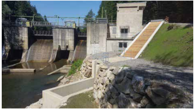
Die neuerbaute Fischaufstiegshilfe (rechts im Bild) beim Kraftwerk Stubenbergklamm © www.feistritzwerke.at/umweltkraftwerke
