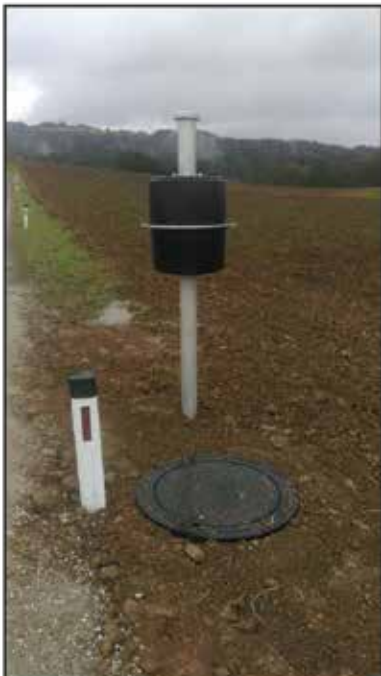
Integration eines eigens konzipierten Ausgasschachtes © TU Graz
