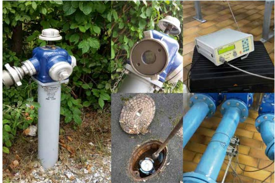
Während Durchflussmessungen nur an wenigen, bestimmten Punkten im System ohne Grabungsarbeiten und damit ohne erhöhte Kosten installiert werden können (z. B. in Schächten oder bei Behältern), können Drucksensoren zusätzlich auch an Hydranten oder an Hausanschlüssen (auch als temporäre Messeinrichtungen) angebracht werden. © TU Graz, Siedlungswasserwirtschaft
