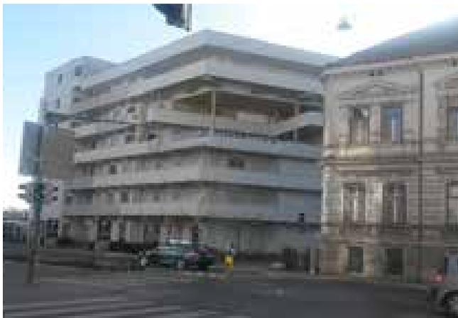
Hier wieder einige Negativbeispiele: Ganz groß in Mode: Die Gänge werden in das Freie verlegt, wodurch es möglich ist, de facto die vorhandenen Baukubatur zu umgehen, bzw. zu überschreiten, da die freiliegenden Gänge nicht in die Bauflächen eingerechnet werden.
