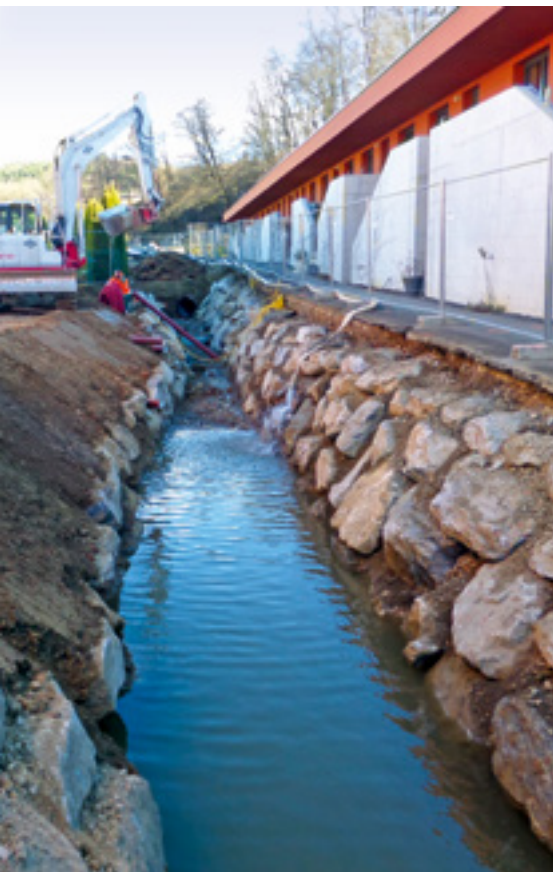
Abb. 4: Hochwasserschutzmaßnahmen Stufenbach - Bachöffnung © Eisner ZT GmbH / Rakusch
