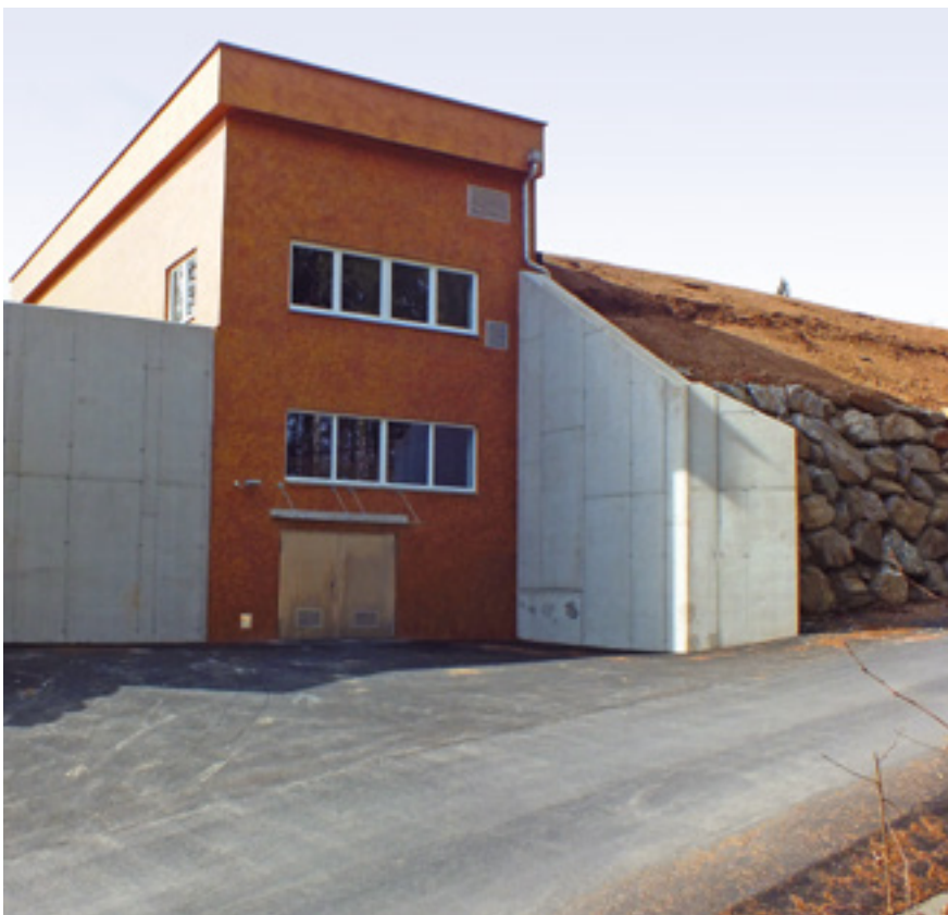
Abb. 1: Der Hochbehälter deckt kurzfristige Verbrauchsspitzen ab. © Wasserverband Umland Graz
