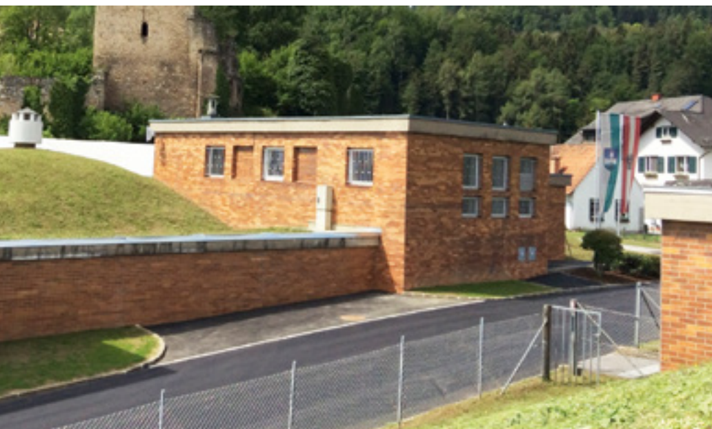
Abb. 1: Wasserversorgungsanlage in Sturmburg © W. Ederer – Stadtgemeinde Weiz
