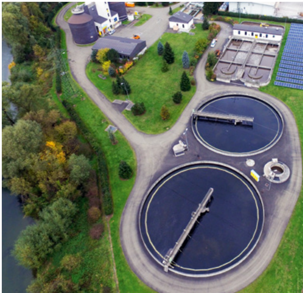
Abb. 2: Kläranlage Kapfenberg – Mürzverband © GSA
