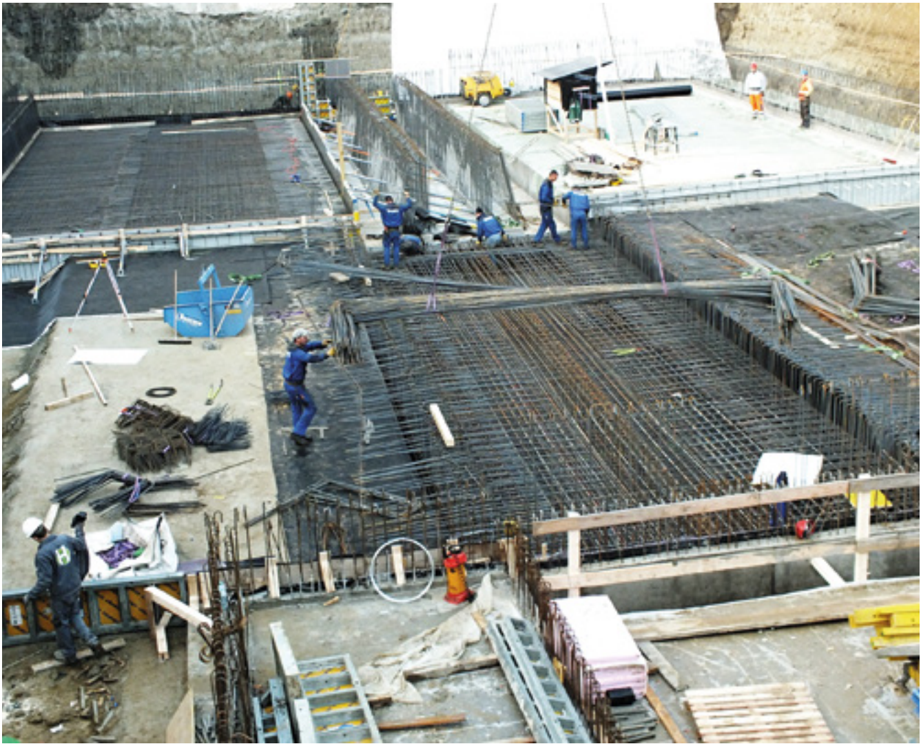
Abb. 2: Errichtungsarbeiten des Hochbehälters in Dobl-Zwaring © Wasserverband Umland Graz
