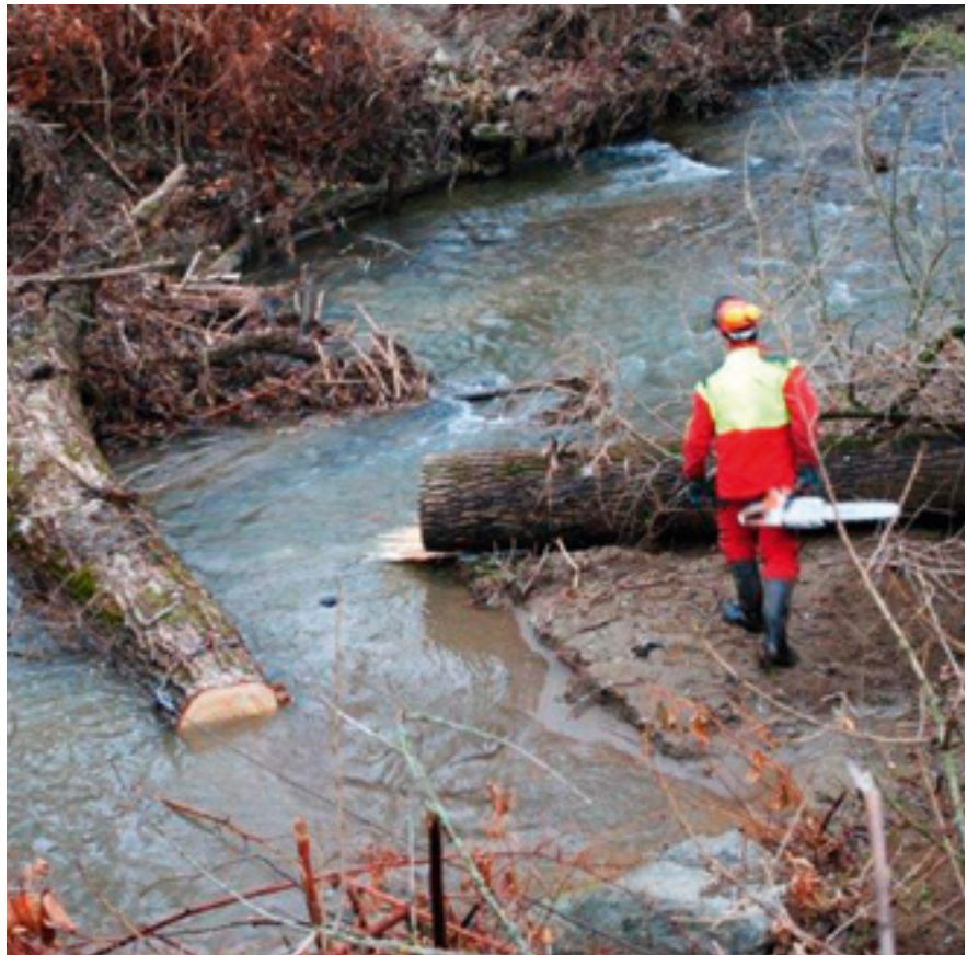
Abb. 6: Gehölzpflege im Rahmen der Instandhaltung von Regulierungsbauten © A14
