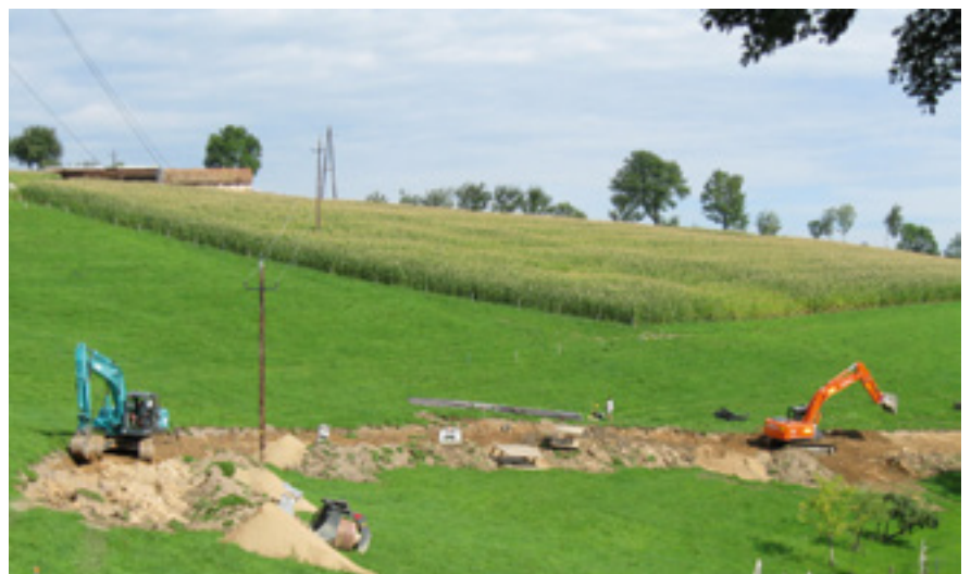
Abb. 1: Kanalbau im ländlichen Raum © GSA
