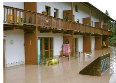
**Schwachstelle Lüftungsschacht.** Über den nicht gesicherten Lüftungsschacht (re.) strömt das Wasser in die darunterliegende Tiefgarage.
