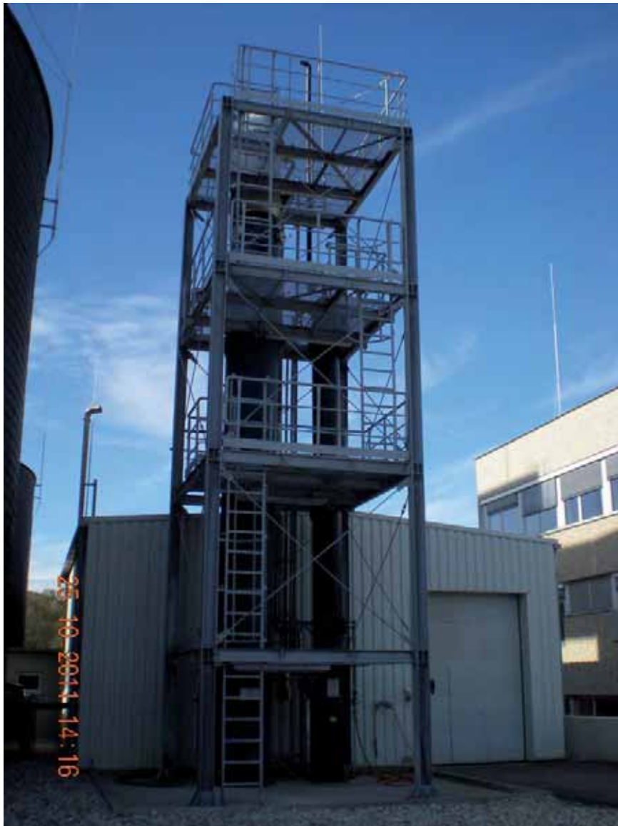
Strippungskolonnen samt Strippungshalle
