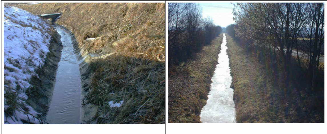
Abb. 111 (links): Betonsohlverbau am Poppendorferbach bei Ludersdorf; Abb. 112 (rechts): Begradigtes Bachbett am Hartelbach südlich von Hürth.
