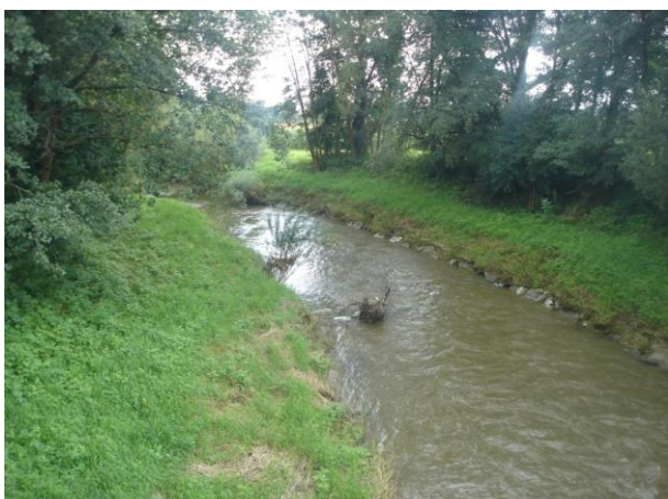
Abb. 33: Kurzer gestreckter und verbauter Lafnitzabschnitt beim Meierhof südlich Rohrbrunn.
