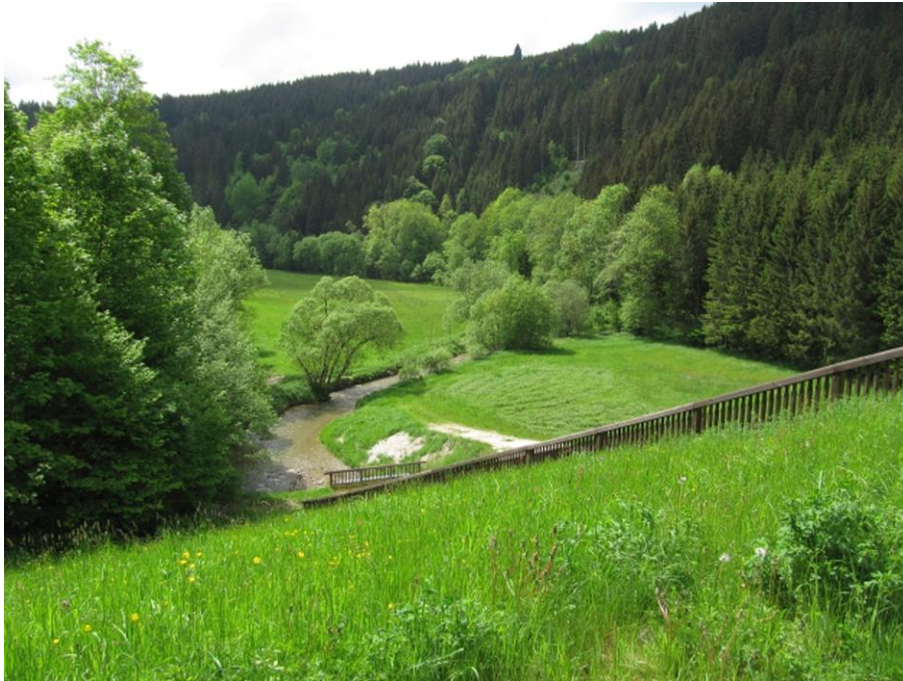
Abb. 4: Blick vom Hochwasserrückhaltebecken an der Lafnitz oberhalb Waldbach stromaufwärts.
