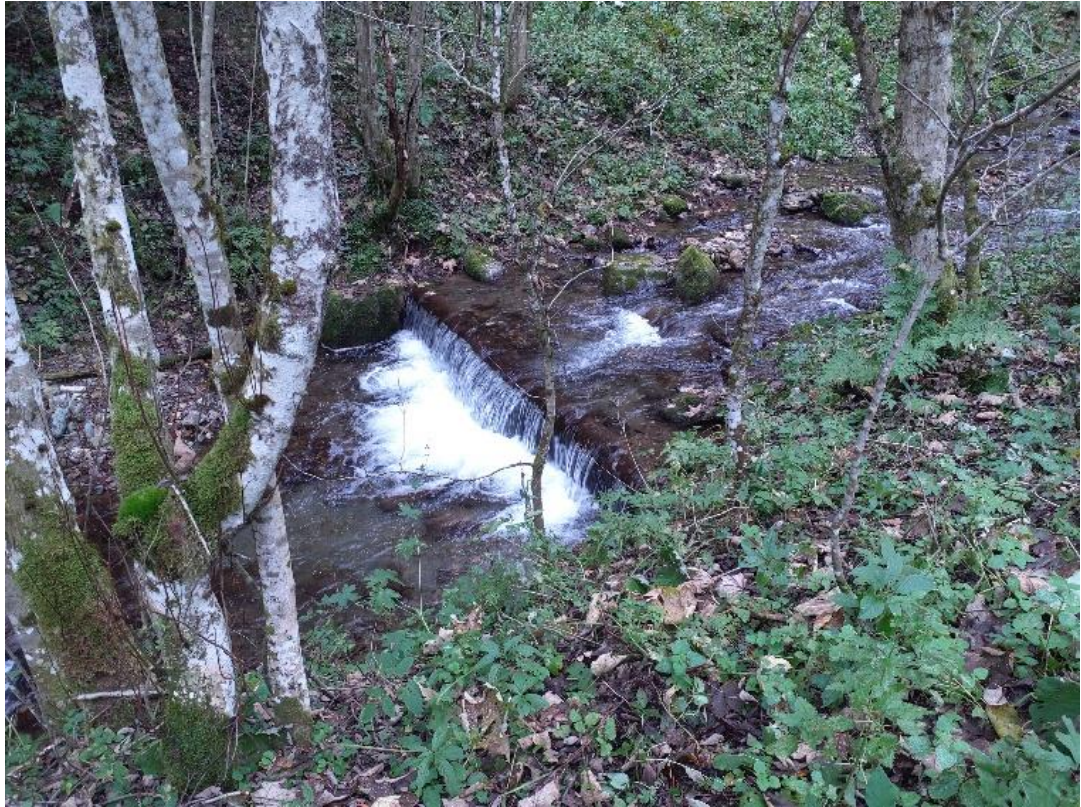
Abbildung 39. Querbauwerk im Gößgraben, ca. 50 m unterhalb der Mündung des Tullingerbachs. © Preßnitz
