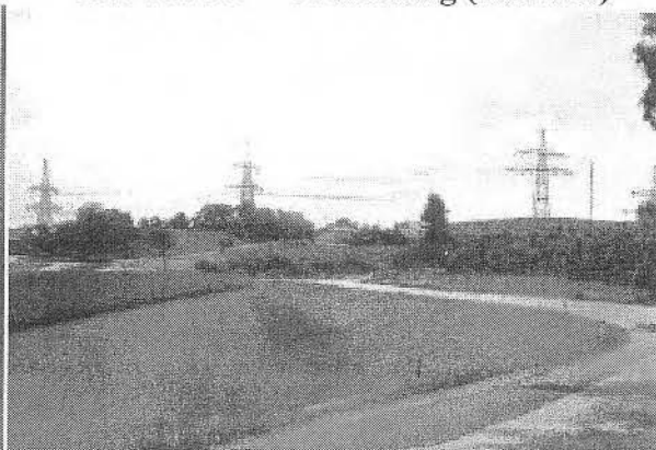
Mit 380 KV – Freileitung (nachher)
