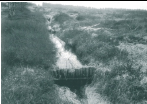
Abb. 19: Damm zur Grabenabdichtung (aus: ROTHSTEIN 1995) und Schema
