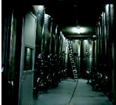
Abb. 2: Kellereiräume mit Tanks
