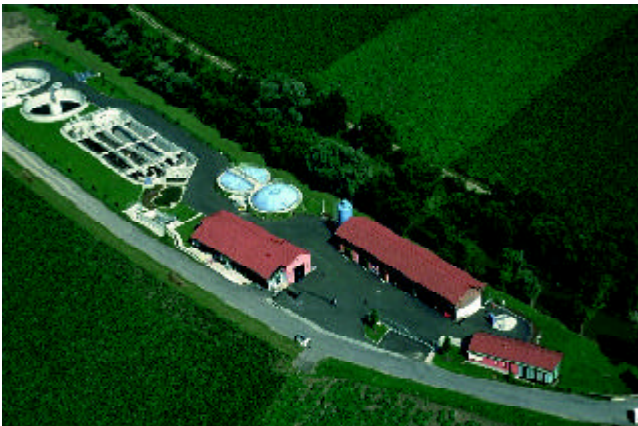
Abb. 4: Kläranlage Radiga (RHV Pößnitz-Sagg.)
