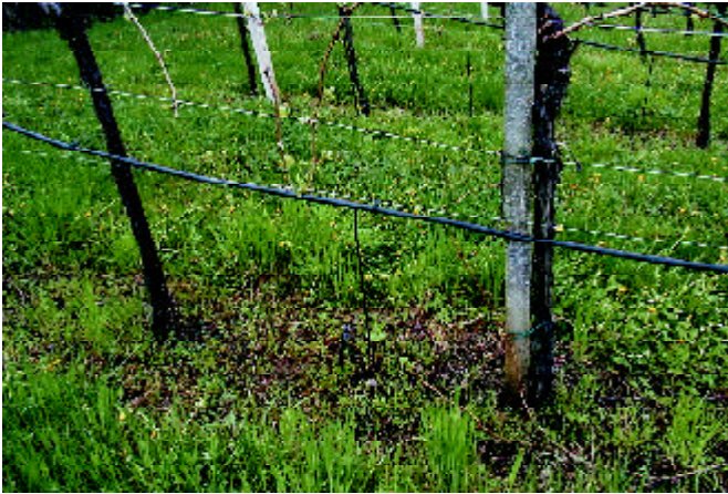
Abb. 6: Verteilungsanlage zur Verrieselung beim Weinbaubetrieb Groß in Ratsch
