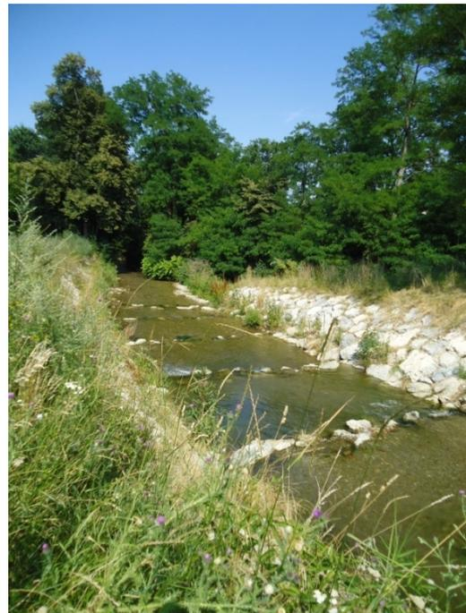
Abbildung 13: Maßnahmen zur Herstellung der Durchgängigkeit: aufgelöste Rampe an der Wulka bei Pöttelsdorf (Foto: Verena Ressel/BMLFUW)
