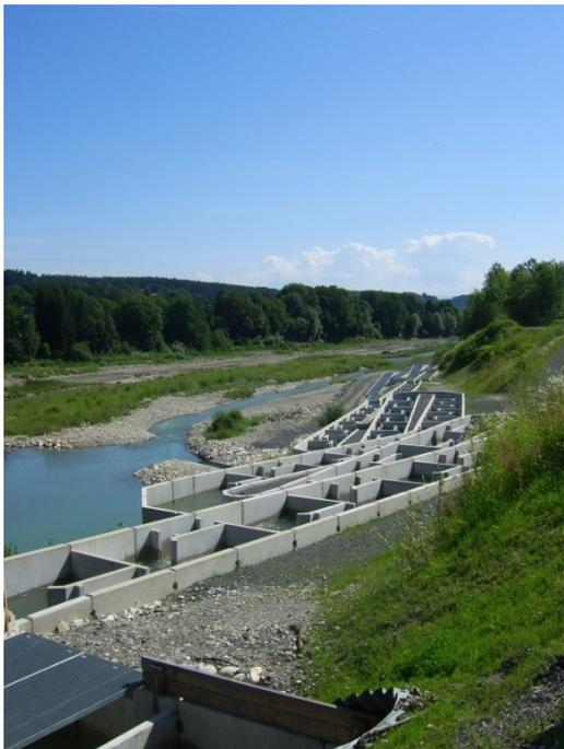
Abbildung 12: Maßnahmen zur Herstellung der Durchgängigkeit: Schlitzpass beim KW Rosegg/Drau (Foto: Katharina Steinbacher/BMLFUW)
