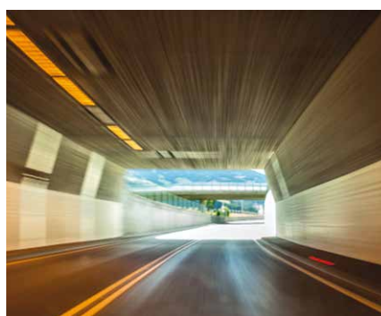
Der Gleinalm- und der Plabutschunnel werden im Jahr 2019 fertiggestellt.
