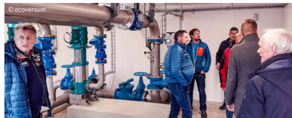
12. April 2023 bei der Wasserversorgung der Stadtwerke Judenburg
